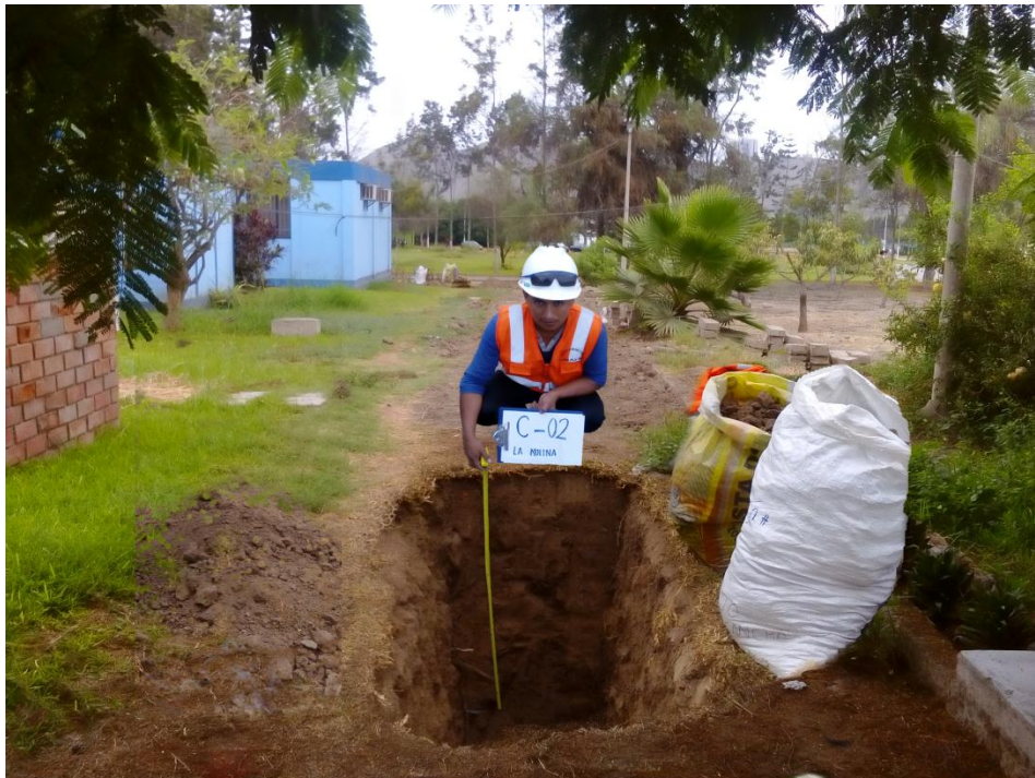
FOTO 4: Identificando la calicata C – 02 y determinando su profundidad.
