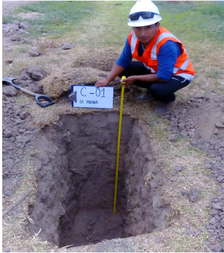
FOTO 3: Identificando la calicata C – 01 y determinando su profundidad.
