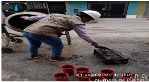
Figura 18: Vaciado de vigas
