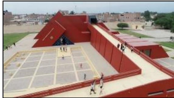
Imagen 2 Rampa de acceso a la planta superior del museo
