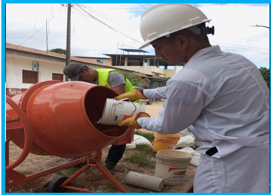
DISEÑO DE CONCRETO F'C=210 KG/CM2 (CONVENCIONAL)
