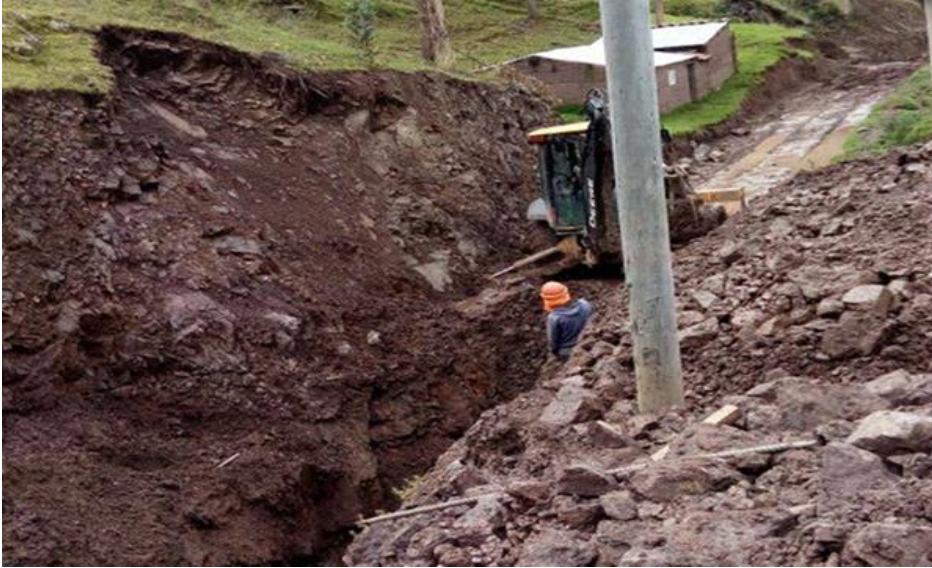
Figura 6. Excavación con la retroexcavadora.
