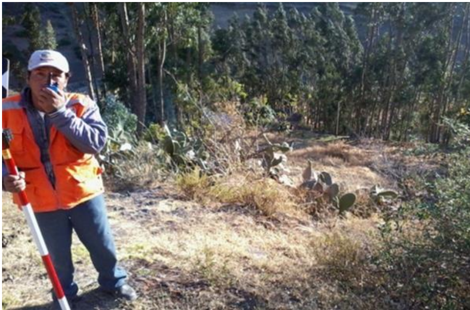
Figura 5. Personal en la actividad de trazo y replanteo.
