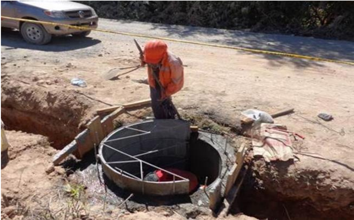
Figura 8. Colocado de concreto en los buzones.
