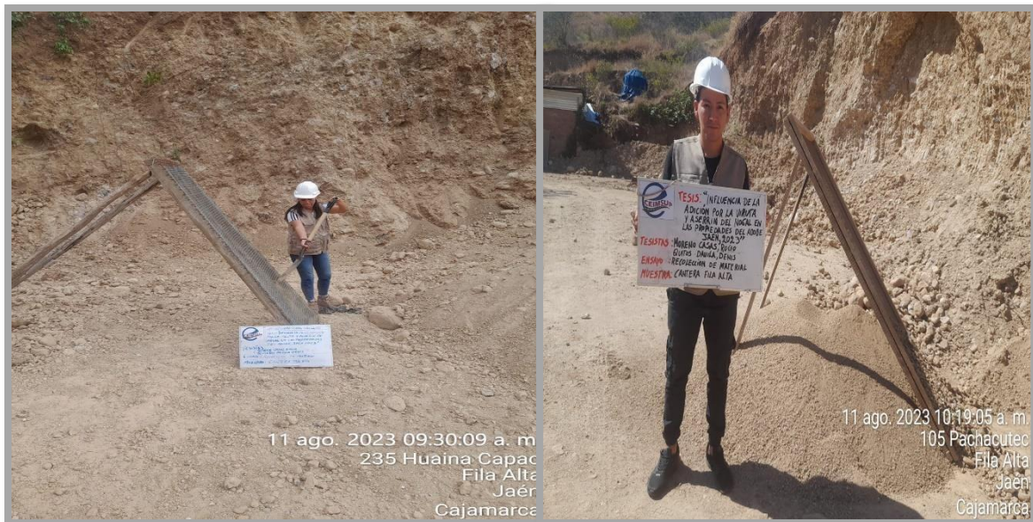
Fotografía 3: zarandeado de material para elaboración de adobes
