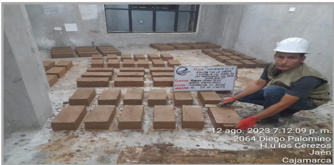
Fotografía 6: Elaboración de adobes
