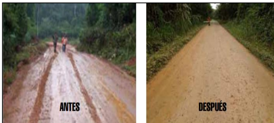
Figura 4. Aplicación de la estabilización Antes y después.
