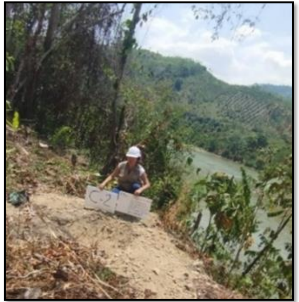
Figura 43. Excavación de la calicata N°2.
