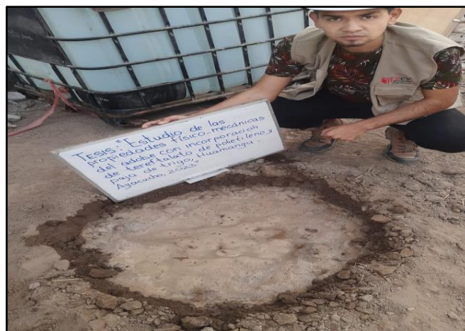
Figura 19. Realización de la mezcla con dosificaciones para el adobe
