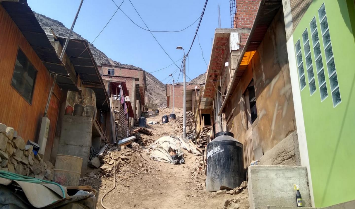
Figura 14. Viviendas sin redes de agua potable ni alcantarillado. AAHH. 8 de octubre
