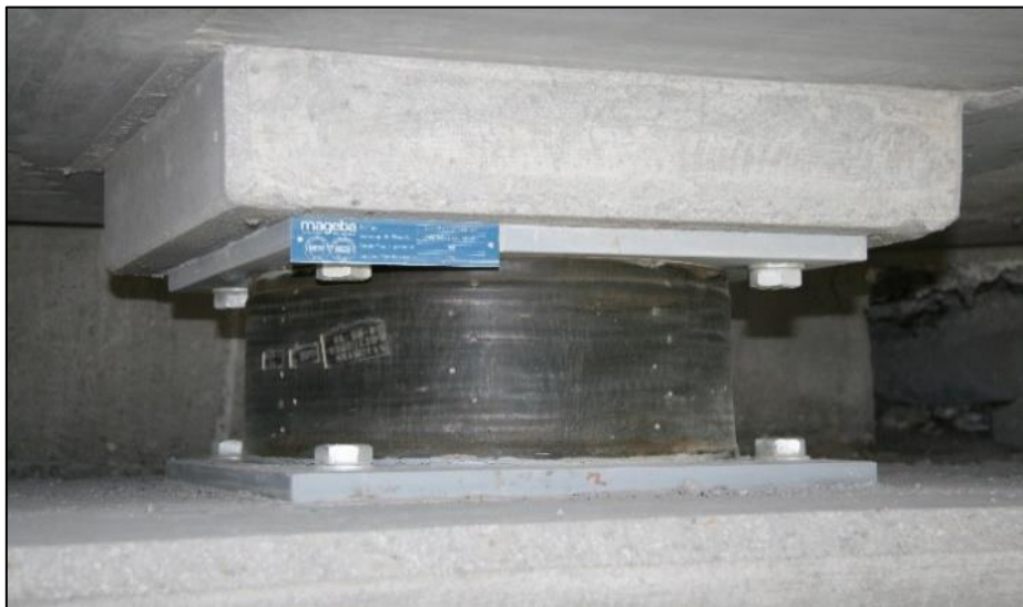
Figura 3. Aislador HDRB
