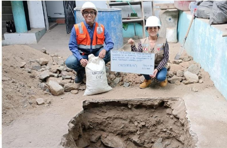
IMAGEN 1: Se puede apreciar la muestra extraída al igual que la excavación realizada.
