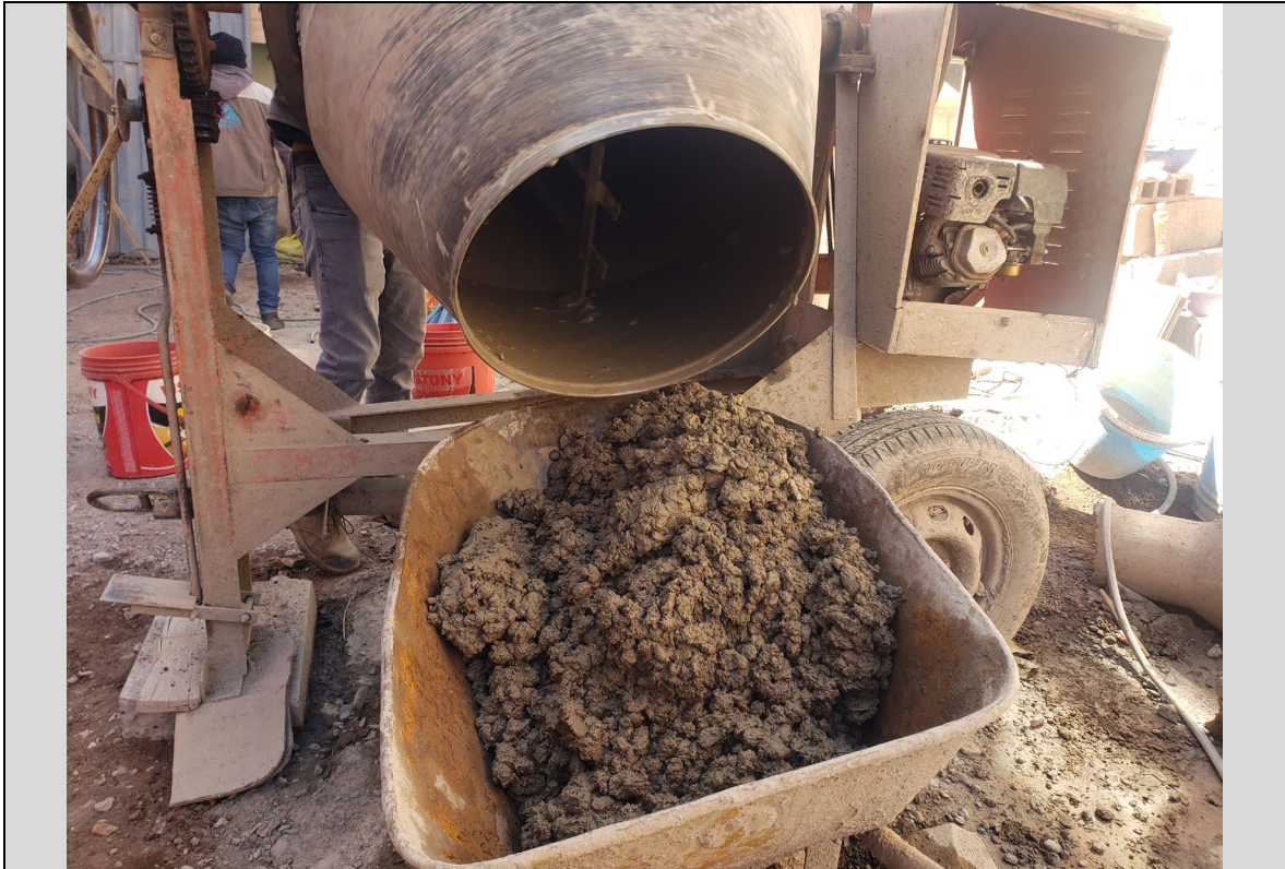
Elaboración de concreto f'c=210 kg/cm 2
