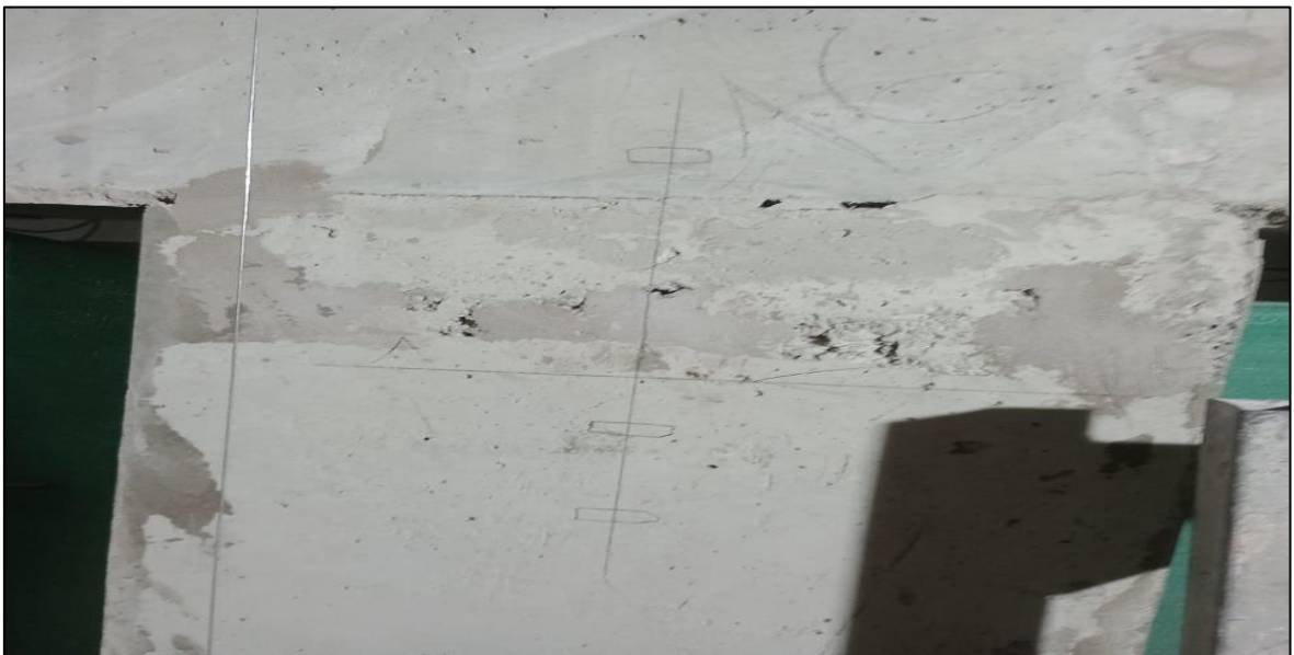
Figura 24. Trazo de nivel y punto de perforación Se puede apreciar el trazado al 100% eje, nivel y puntos de perforación, punto crítico a que si algún error se comete en esta actividad hay riesgo de perjudicar el proyecto
