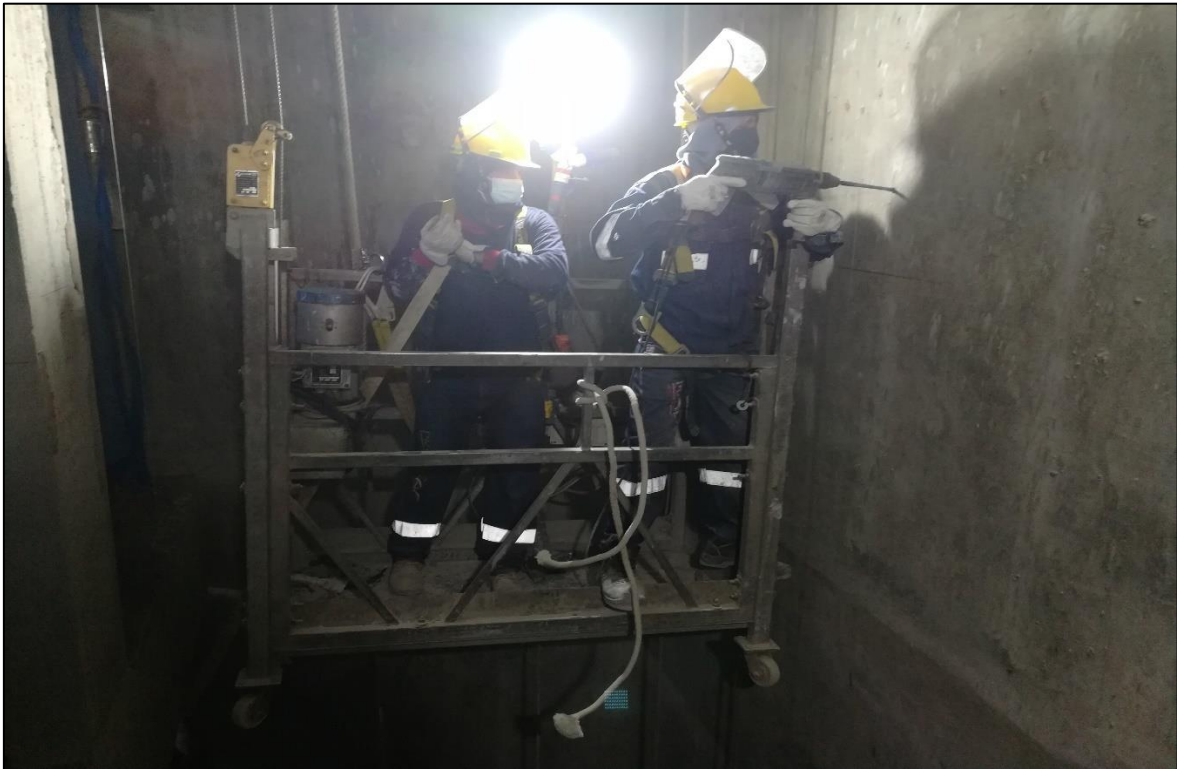
Figura 26. Perforación sobre andamio colgante en ducto del ascensor
