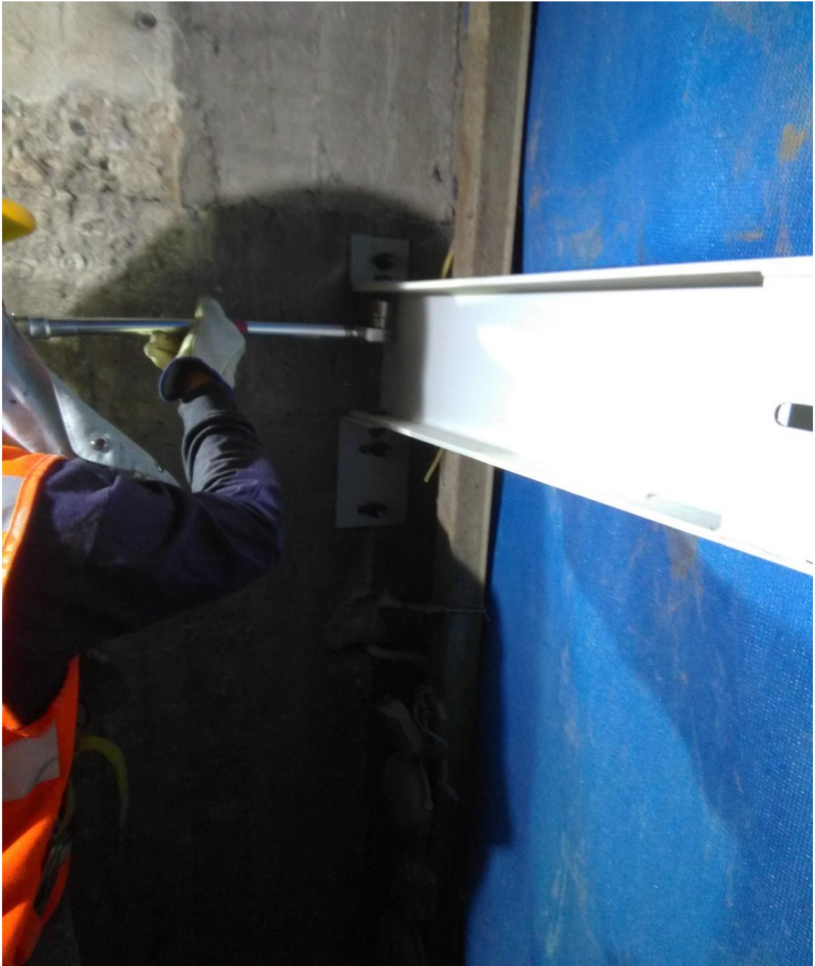
Figura 36. Personal usando el torque
