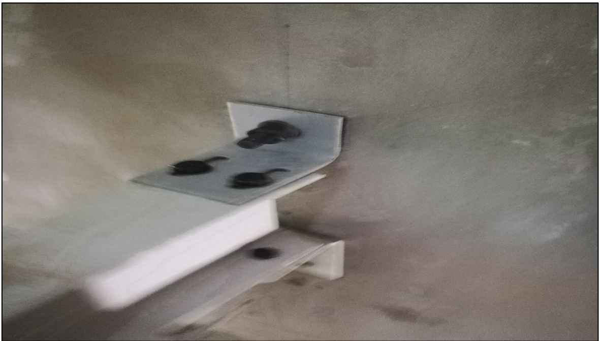
Figura 34. Vigas montada entre clic inferior y clic superior
