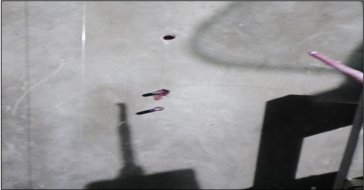
Figura 30. Colocación de esparragos
