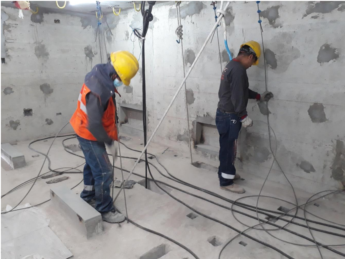
Anexo 27. Isaje de cables acerados para montaje de andamio colgante, sala de maquinas
