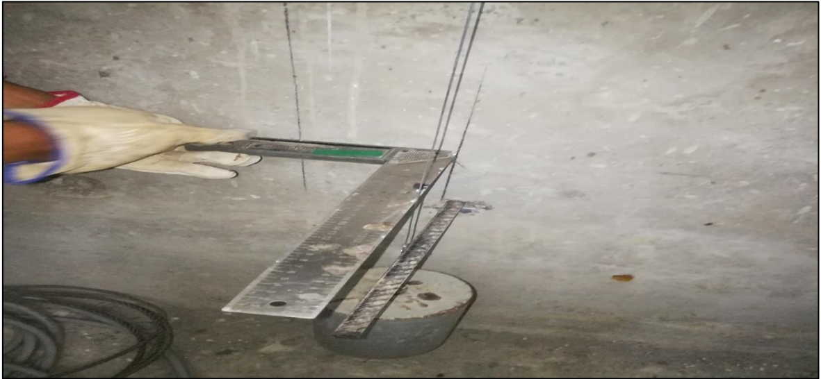
Figura 23. Fase 2 del montaje, trazado de niveles puntos de perforación En la imagen se observa una de las tareas “trazar eje” con ayuda de la plomada para cada nivel de perforación.
