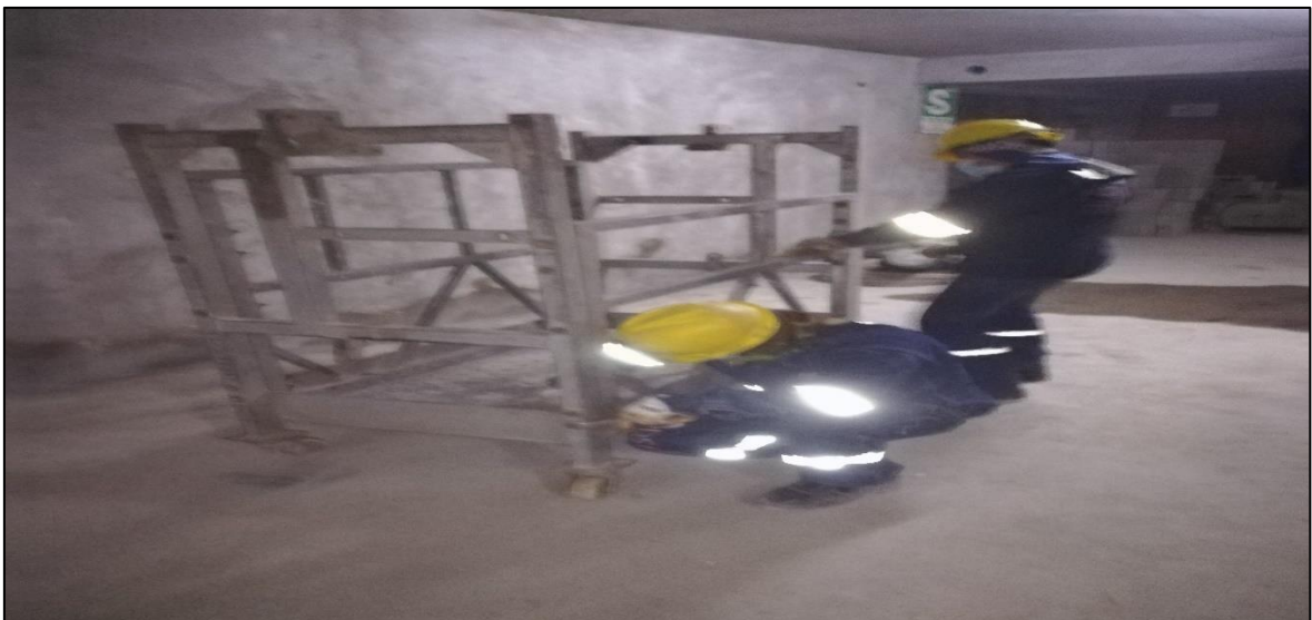
Figura 22. Montaje de andamio colgante
