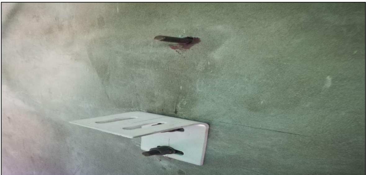
Figura 32. Clic inferior instalado
