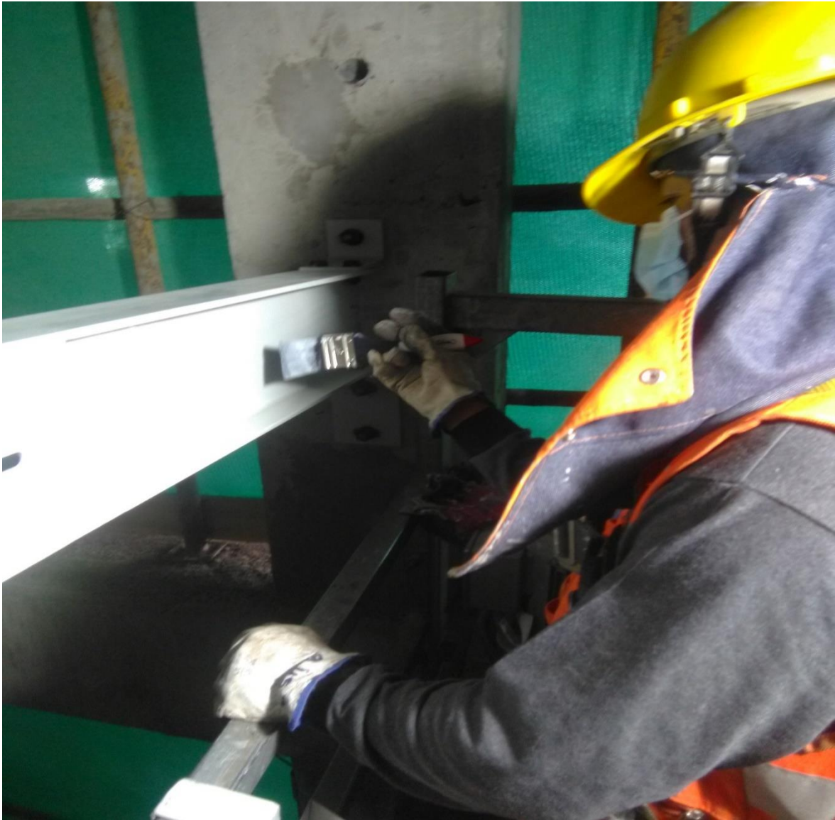
Figura 38. Retoque de vigas con pintura
