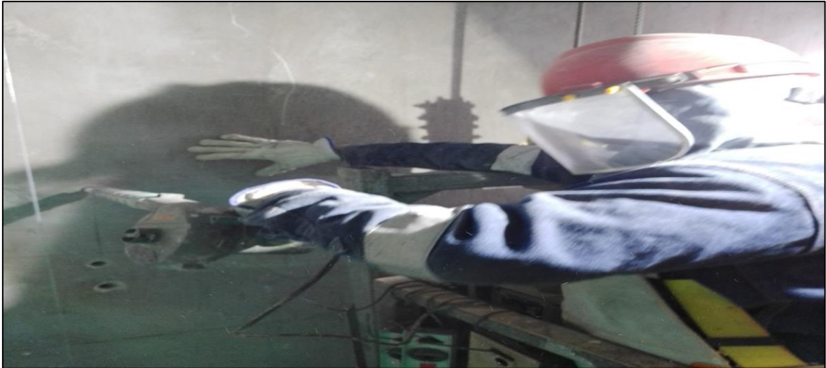
Figura 28. Limpieza de perforaciones
