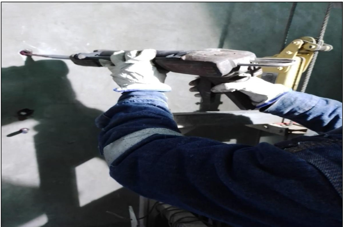
Figura 29. Aplicación de resina epoxica
