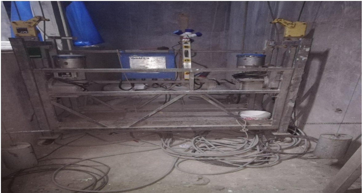
Anexo 28. Andamio colgante armado dentro del pozo
