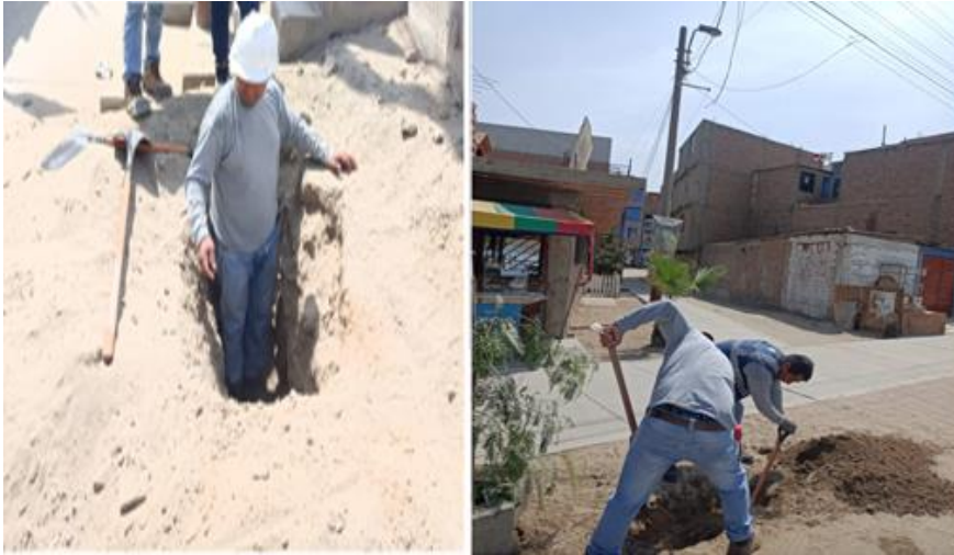
Figura 17.Excavación de calicata.
