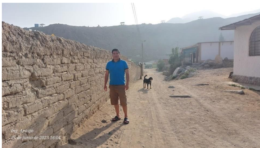
Figura 2 Cerco perimétrico construido a base de adobe
