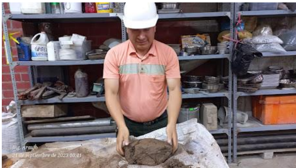
Figura 19 Amasado de la fibra y la tierra (barro)
