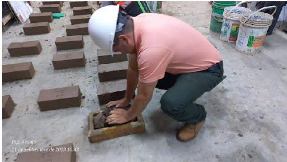
Figura 21 Moldeado del barro en la adobera
