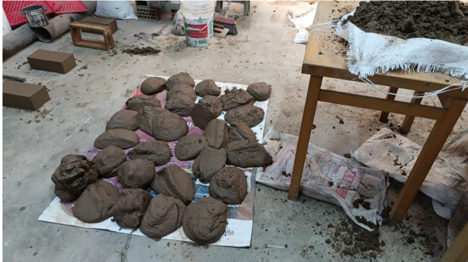
Figura 20 Amasado de la fibra y la tierra (barro)
