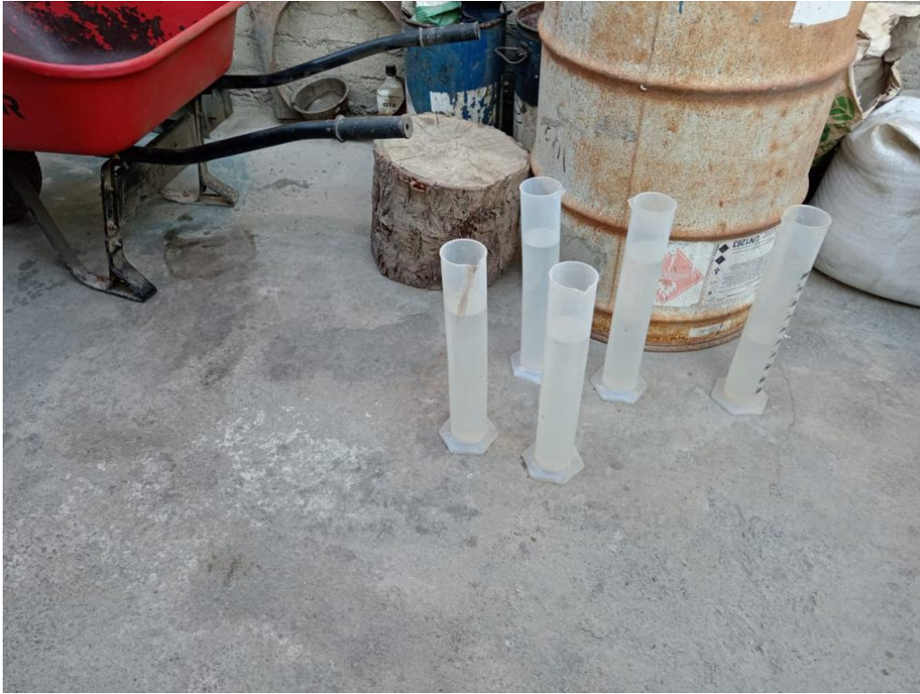
Imagen 12. Agua potable para la elaboración del concreto 175kg/cm 2
