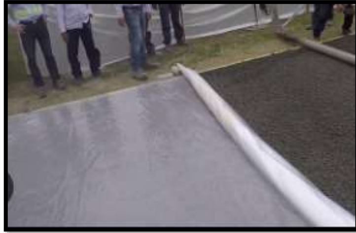
Figura 03. Forma de curado del concreto permeable
