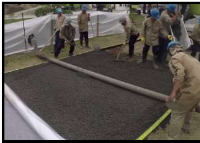
Figura 02. Compactación de concreto permeable con un rodillo
