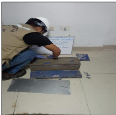
Figura 48. Desencofrado de viga Fuente: Elaboración propia
