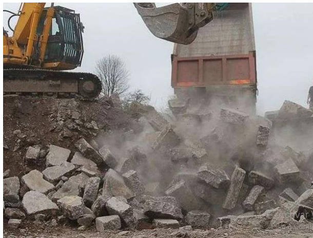
Figura 11. Restos de las demoliciones de construcciones
