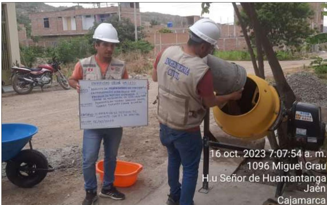
Colocación del agregado grueso en la mezcladora
