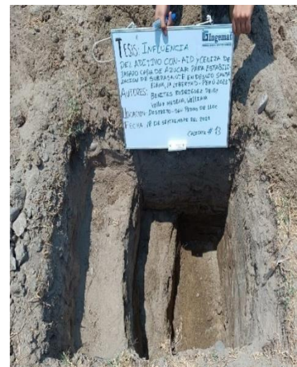
Figura 4. Excavación calicata N° 13.
