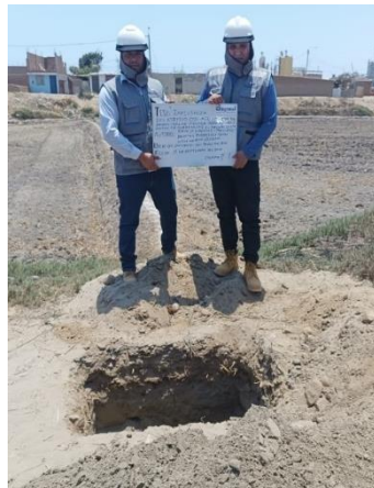
Figura 3. Excavación de la calicata N°4.
