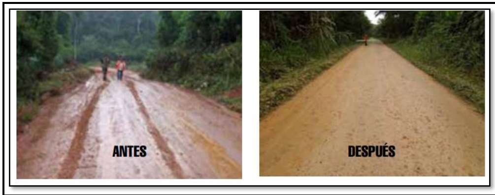
Figura 7: El antes y después de la aplicación de la estabilización
