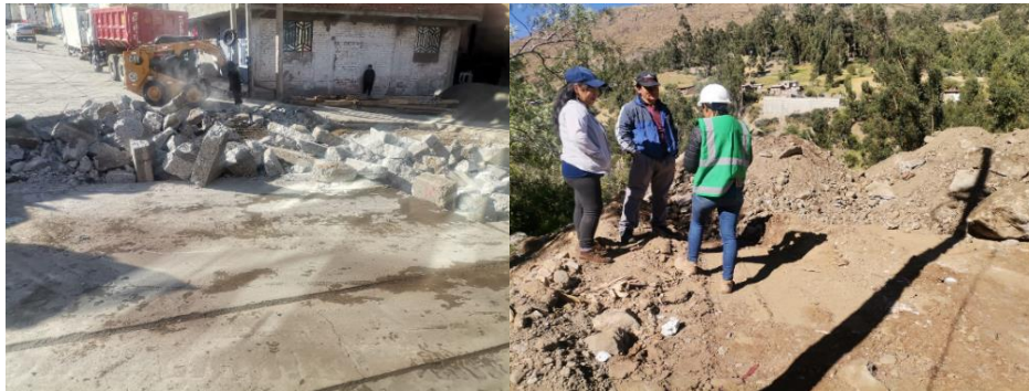
Figura 27. Recolección de agregados reciclado desechado
