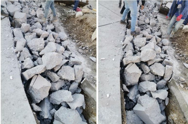
Figura 12. Árido procedente de hormigón reciclado
