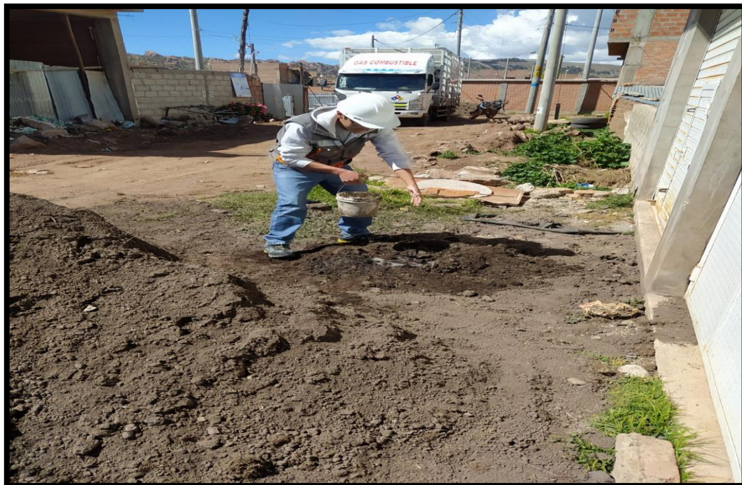
Fotografía 6. Hidratación del suelo para activar sus partículas de arcilla previo moldeo
