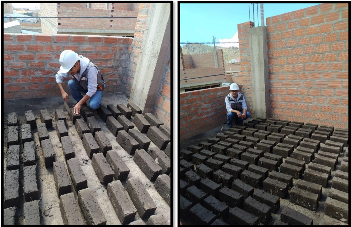
Fotografía 11. Apilamiento del adobe para mejorar el secado y a si mismo su almacenamiento.
