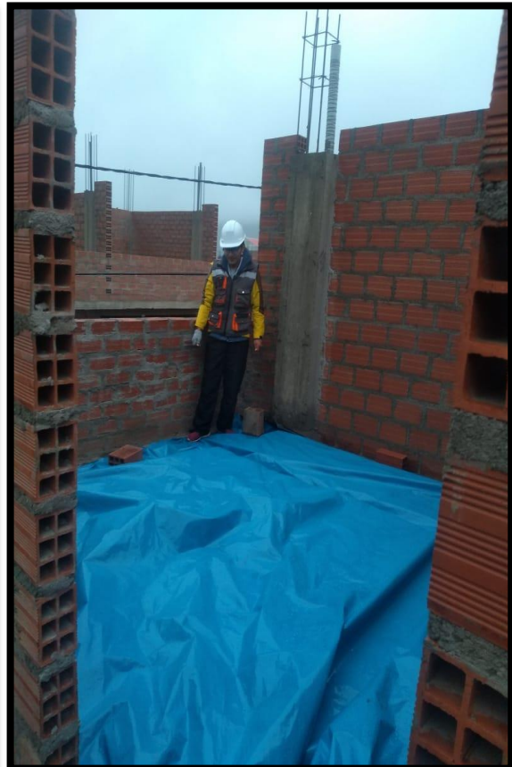
Fotografía 9. Secado de los bloques de adobe y cuidando de los cambios climáticos como es la lluvia y la helada.
