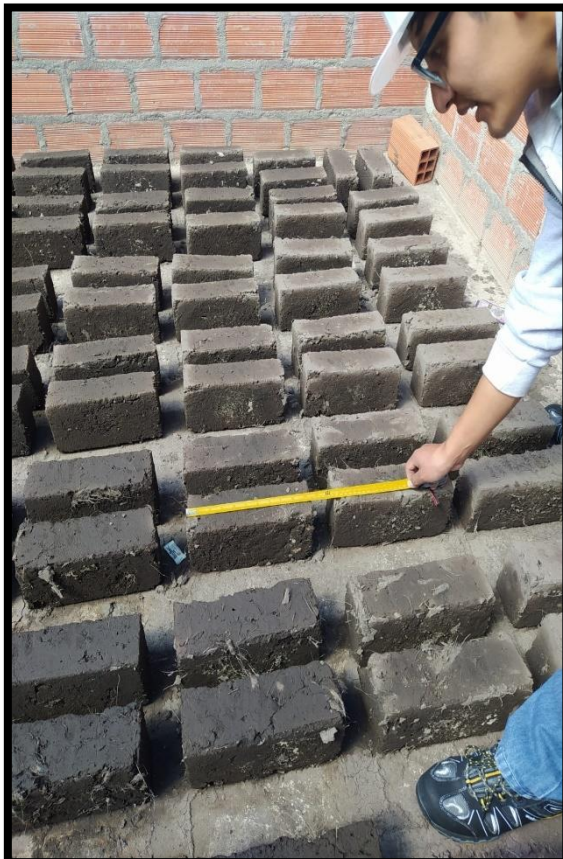
Fotografía 9. Secado de los bloques de adobe y cuidando de los cambios climáticos como es la lluvia y la helada.
