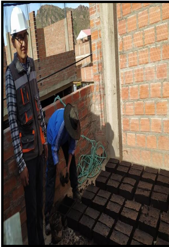
Fotografía 9. Secado de los bloques de adobe y cuidando de los cambios climáticos como es la lluvia y la helada.
