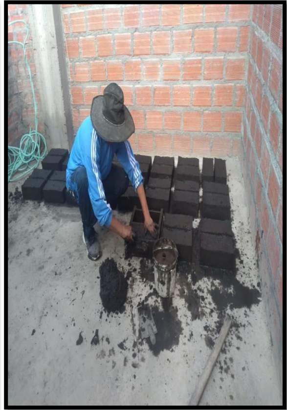
Fotografía 9. Secado de los bloques de adobe y cuidando de los cambios climáticos como es la lluvia y la helada.
