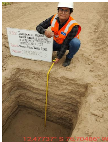
Excavación de calicata C-3
