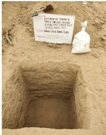
Toma de muestra de la calicata C-2
