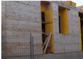
El material base para esta construcción son los bloques de tierra comprimida. (BTC)
