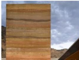
El material base para esta construcción proviene del mismo lugar, como la tierra utilizando el método tierra apisonada.
