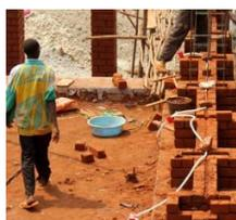
Materiales locales, la tierra para albañilería y acabados, arcilla para las tejas del techo y del piso.
