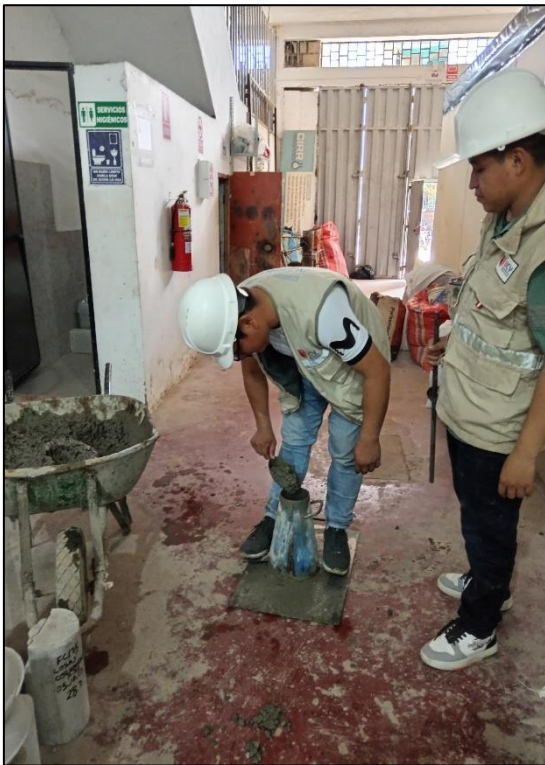
Figura F: Se aprecia el ensayo de Consistencia mediante el cono de Abrams.
