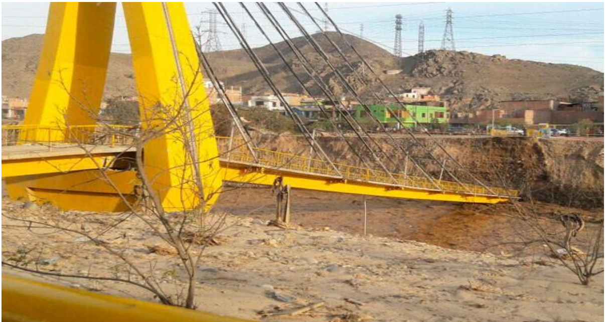
Figura 16. Puente Solidaridad, colapso
