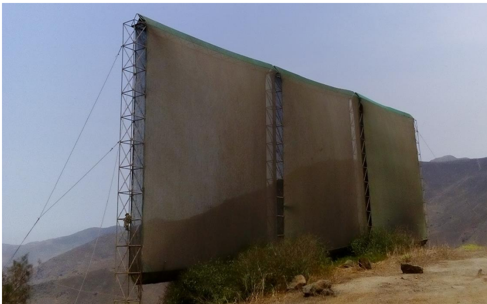
Figura N° 5: Panel de atrapanieblas ubicado en una de las colinas de Paraíso, de tres cuerpos cada uno de ellos de 6 m por 6 m, con la capacidad de captar 27 m 3 litros por noche.
