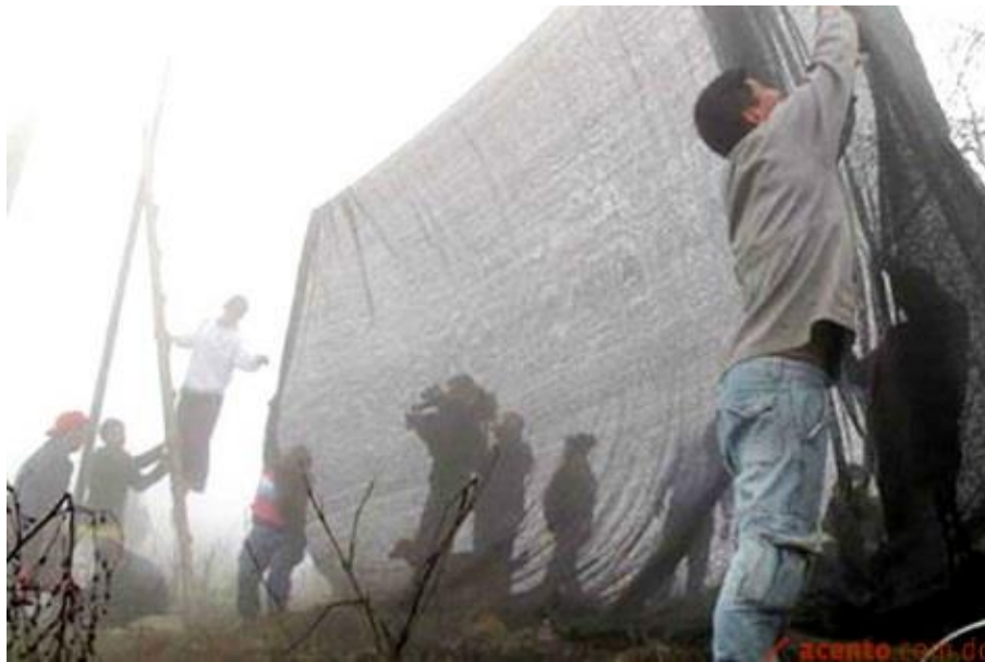
Figura N° 10 : Pobladores instalando atrapanieblas en las colinas de Edén de Manantial Villa María del Triunfo.
