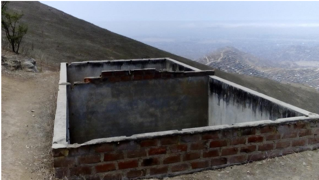
Foto N° 6: Tanque de ladrillo y cemento para almacenar agua
