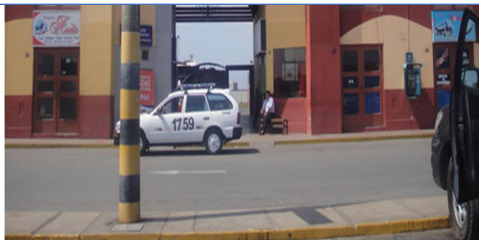
FACHADA DETERMINAL TERRESTRE DE CHIMBOTE.
