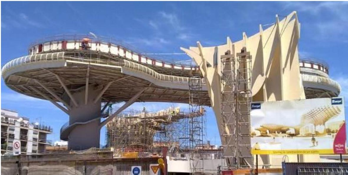
**Acero:** Las uniones en las intersecciones de las numerosas piezas fueron realizadas mediante barras de acero encoladas, de fácil optimización para un rápido montaje en obra.
