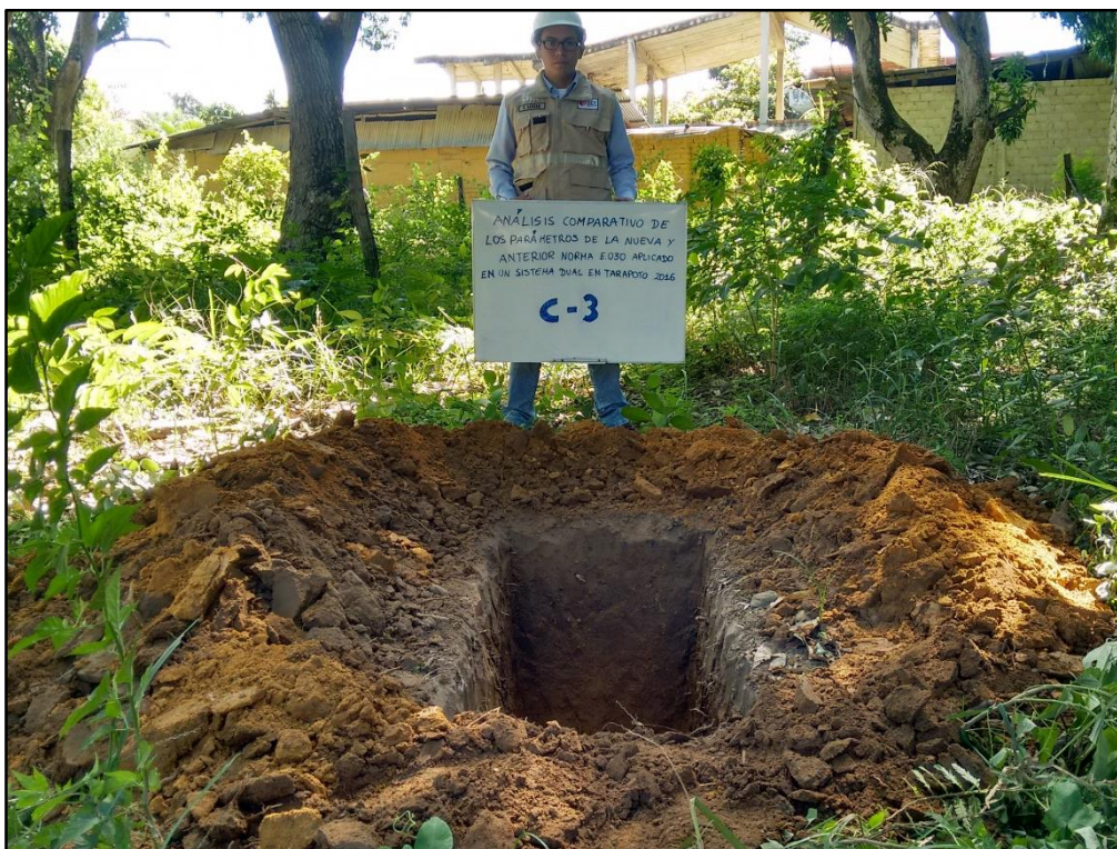
Foto 6: Extracción de muestras de la calicata N° 3
