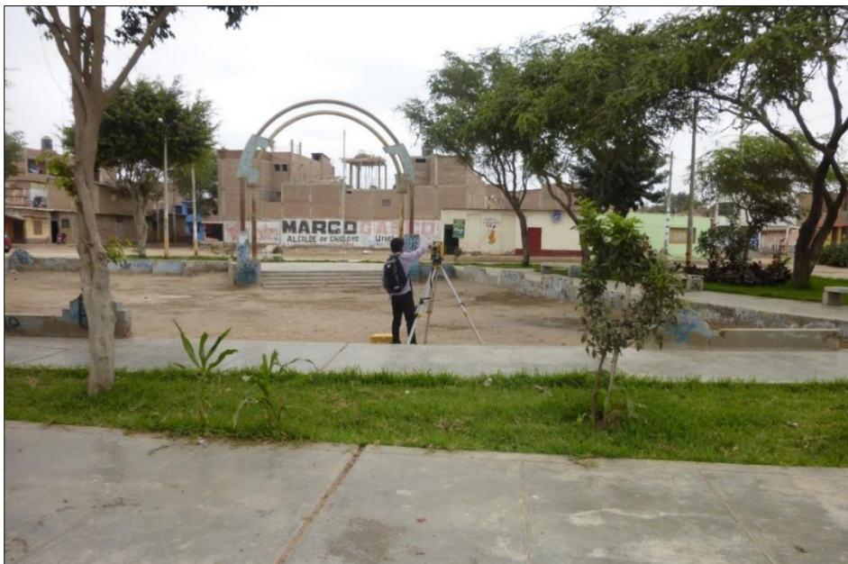
FOTO N° 08 LEVANTAMIENTO TOPOGRAFICO EN LA ZONA.
