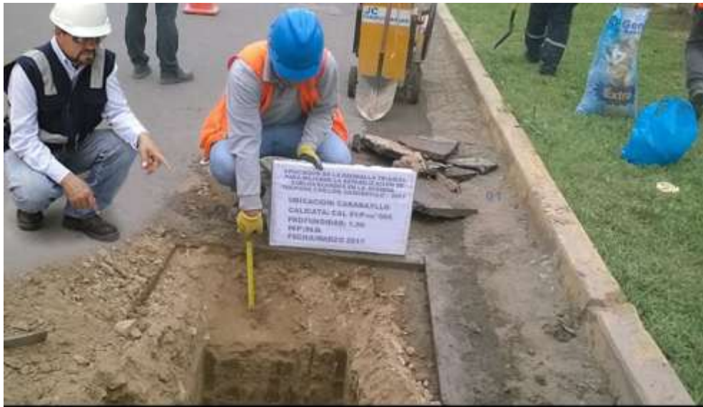
Calicata 01 (Elaboración propia)
