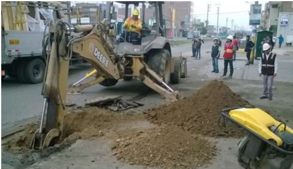
Excavación calicata (Elaboración propia)
