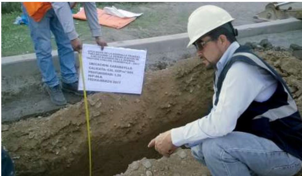
Calicata 02 (Elaboración propia)
