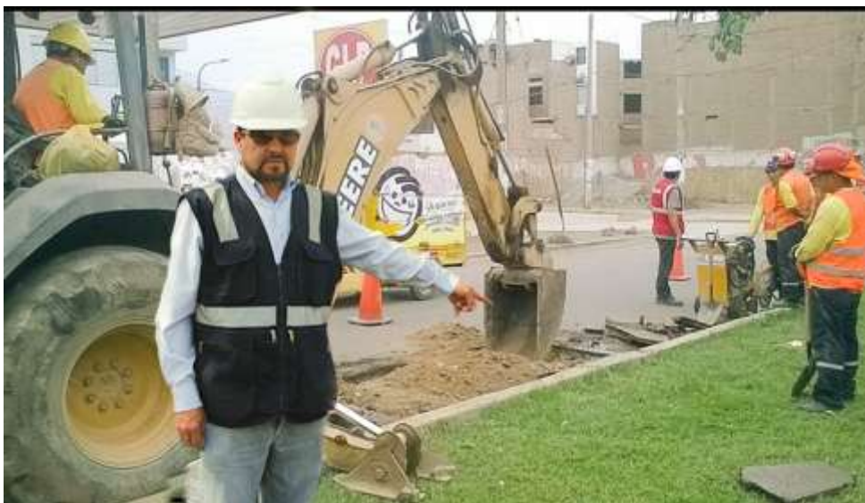
Excavación calicata 01 (Elaboración propia)
