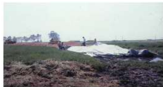
Fig. 1. 12. (Izq) Gráfico típico para diseño, (Der) Construcción de una vía no pavimentada reforzada sobre arcilla orgánica blanda.
