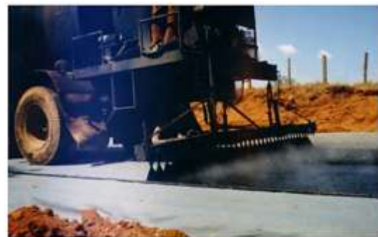
Fig. 1. 13. (Izq.) Daños en un pavimento convencional, (Der.) Aplicación de geosintéticos en pavimentos
