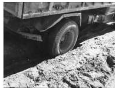
Fig. 1. 10. Mecanismos típicos de degradación en vías con pavimento no reforzado sobre suelos blandos
