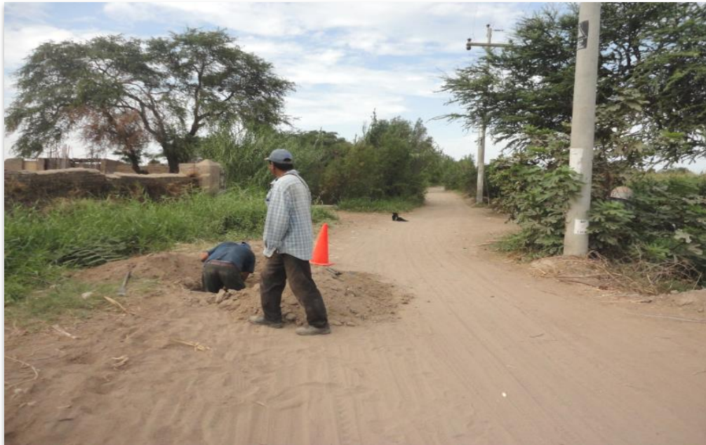
EN LA VISTA SE APRECIA PERSONAL CONTRATADO PARA REALIZACION DE CALICATA Y EXTRACCION DE MUESTRAS
