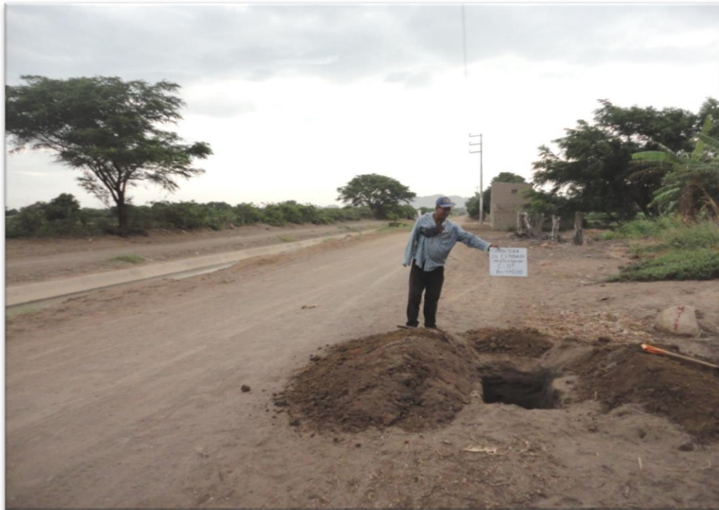
EN LA VISTA SE APRECIA PERSONAL CONTRATADO PARA REALIZACION DE CALICATA Y EXTRACCION DE MUESTRA
