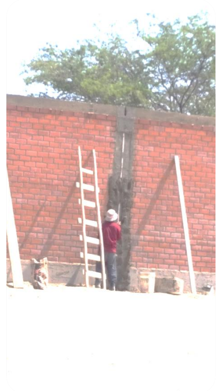
Foto 06: Operario en trabajo Contributorio en tarrajeo de columna en cerco perimétrico.
