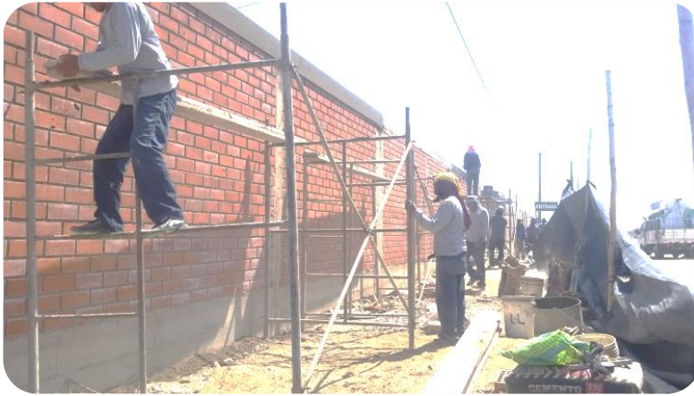
Foto 04: Operario en trabajo Contributorio en tarrajeo de viga collarín en cerco perimétrico, ayudante en trabajo No Contributorio.
