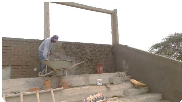
Foto 09: Operario en trabajo Contributorio en tarrajeo de muros bajos en gradería.
