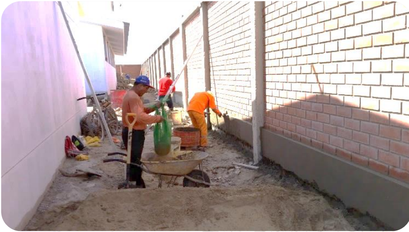
Foto 01: Operario trabajo productivo en tarrajeo de Sobre cimiento en cerco perimétrico y ayudante ejecutando limpieza.
