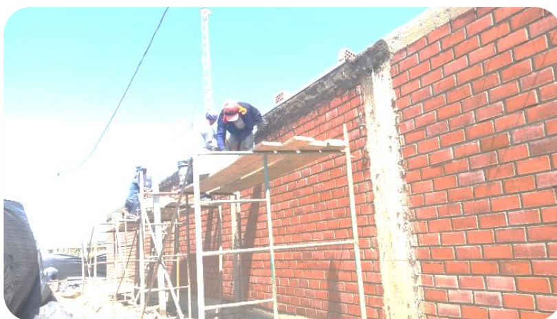
Foto 03: Operario en trabajo contributorio en tarrajeo de viga collarín en cerco perimétrico
