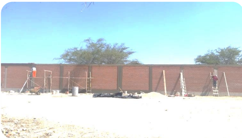
Foto 06: Operario en trabajo Contributorio en tarrajeo de columna en cerco perimétrico.
