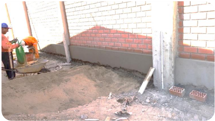
Foto 02: Operario en trabajo contributorio en tarrajeo de Sobre cimiento en cerco perimétrico y ayudante en trabajo contributorio de zarandeo de agregado.
