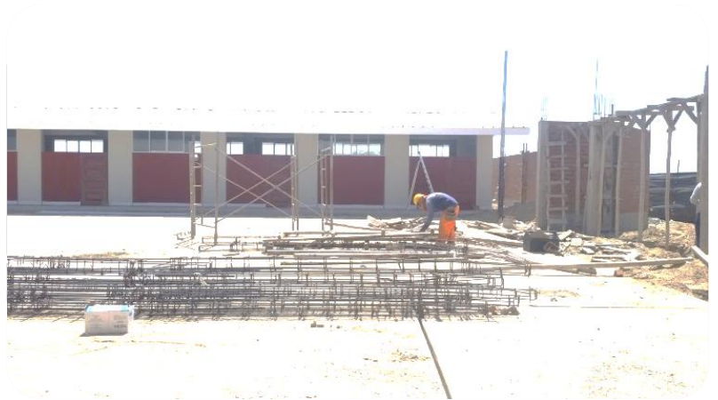
Foto 08: Operario en trabajo Contributorio en encofrado de viga.
