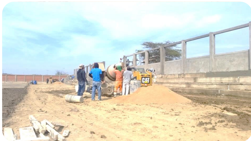
Foto 11: Ayudantes en esperas por mezcla de concreto.
