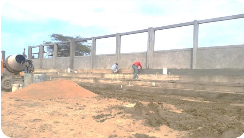
Foto 10: Operario en trabajo productivo en forjado de graderías.
