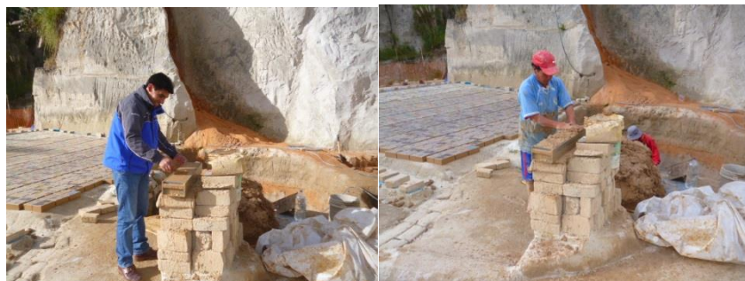
Fig. 1.10. Moldeo Manual del Ladrillo.
