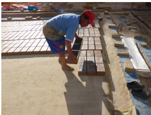
Fig. 1.8. Fabricación del ladrillo en forma artesanal
