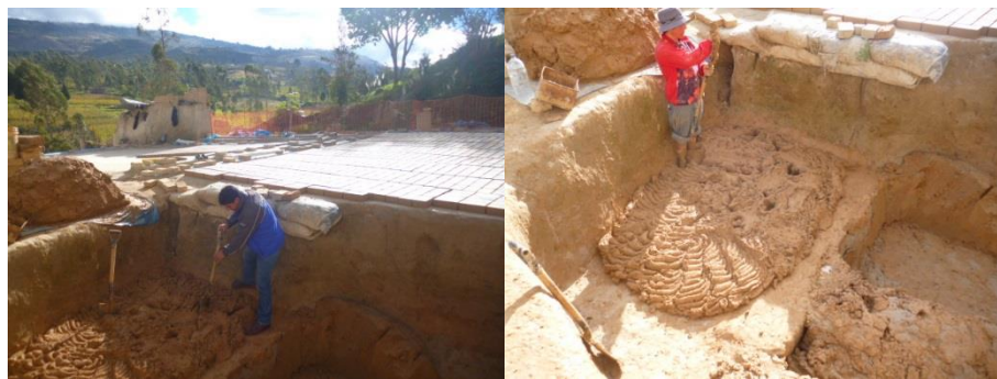
Fig. 1.9. Preparación de la Arcilla.
