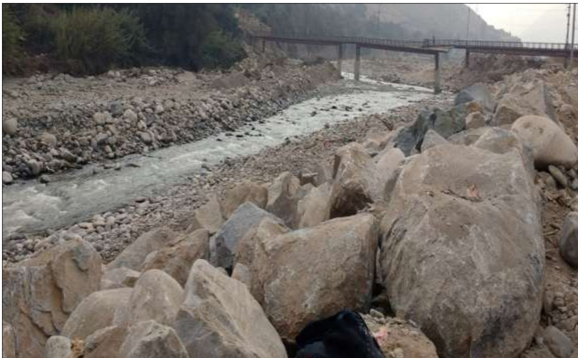
Figura 3. Puente Pérez de Cuéllar punto de referencia, (elaboración propia).
