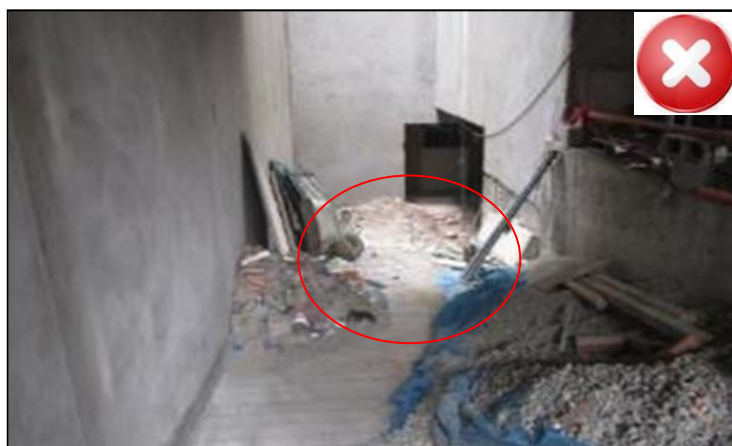
Fig. N° 12: Orden y limpieza
