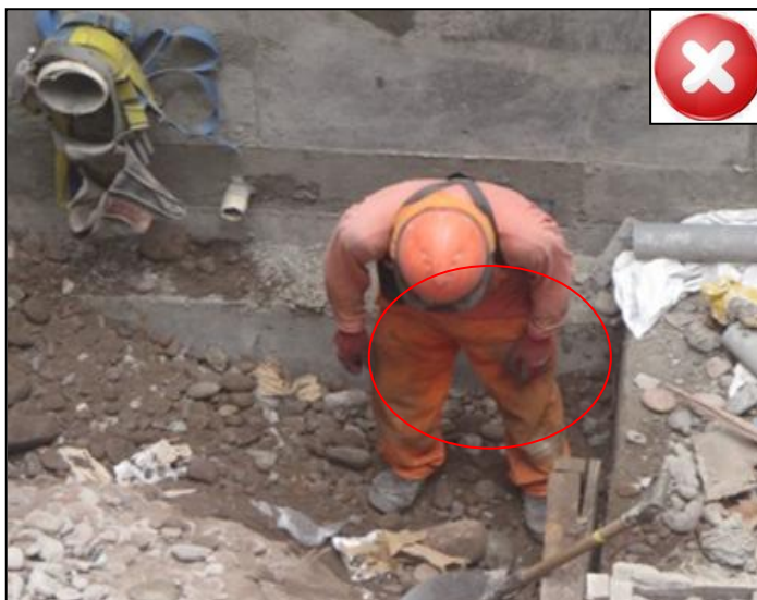
Fig. N° 14: EPP's deteriorados
