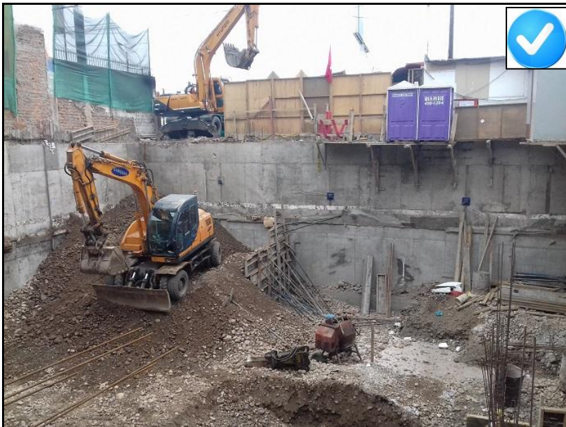
Figura N° 21: Excavación de zanjas
