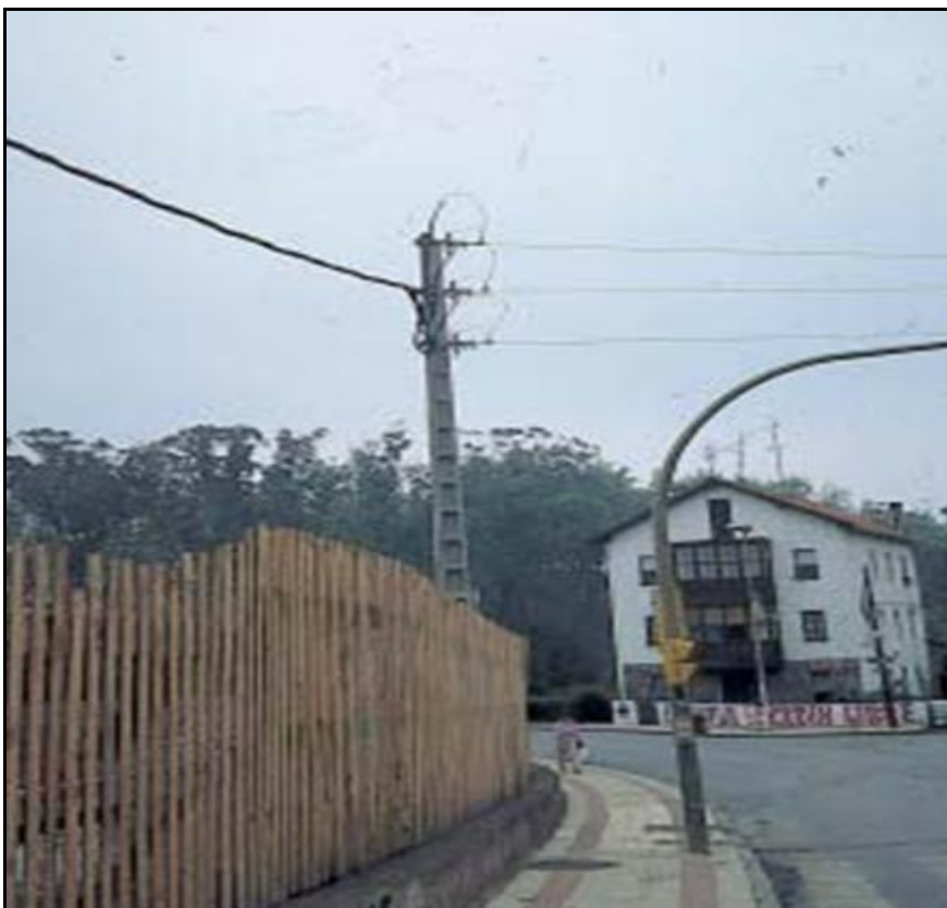
Fig. N° 6: Instalación de cables aislados dentro de la obra
