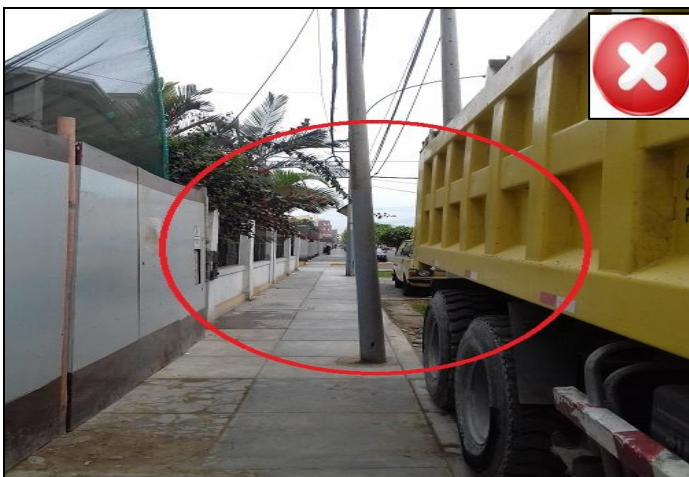
Fig. N° 18: Falta de señalización
