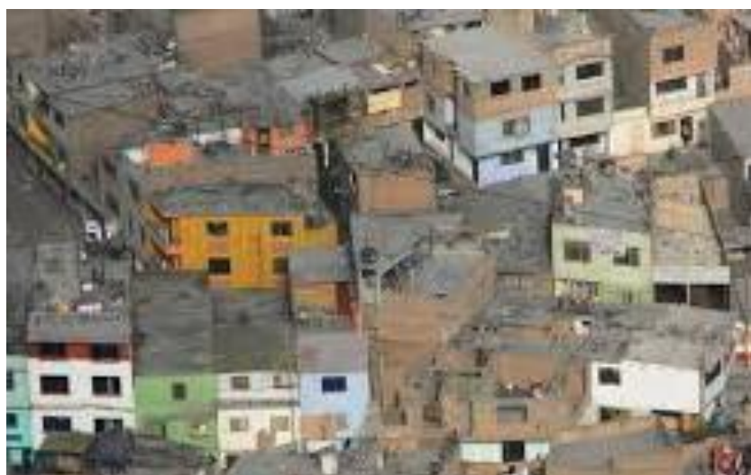
FOTO 4: Las viviendas se construyen sin respeto a la trama urbana
