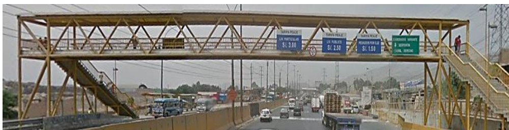
Figura 3.22. Vista fotográfica frontal del puente peatonal Mariátegui
