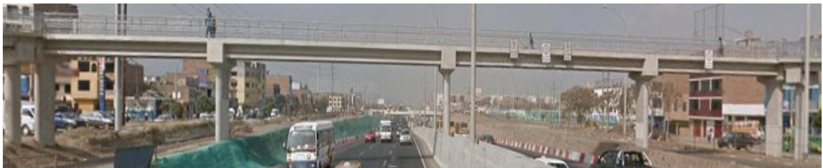
Figura 3.10. Vista fotográfica frontal del puente peatonal Entrada de Pro
