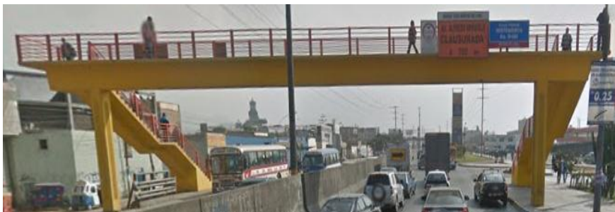
Figura 3.4. Vista fotográfica frontal del puente peatonal Independencia
