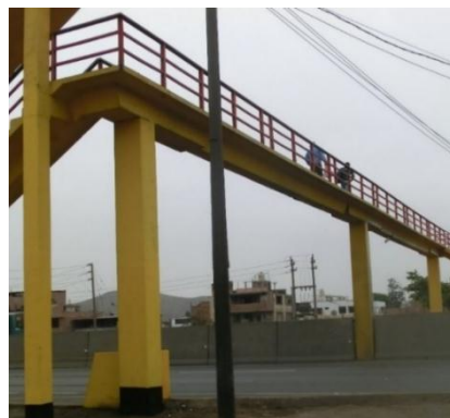
Figura 3.15. Vista fotográfica isométrico del puente peatonal La Amistad
