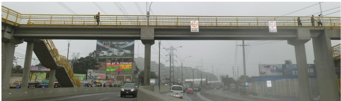
Figura 3.20. Vista fotográfica frontal del puente peatonal Shangrilla
