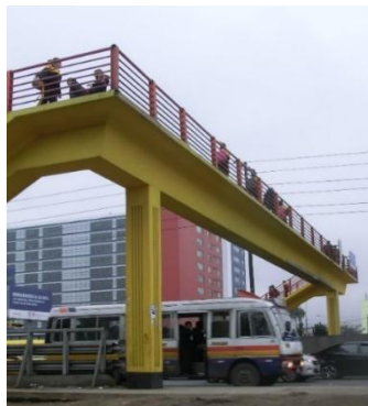
Figura 3.5. Vista fotográfica isométrico del puente peatonal Independencia
