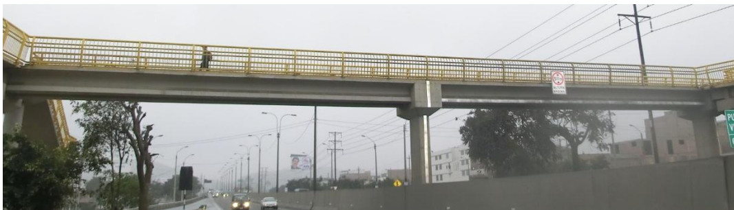
Figura 3.18. Vista fotográfica frontal del puente peatonal Acobamba
