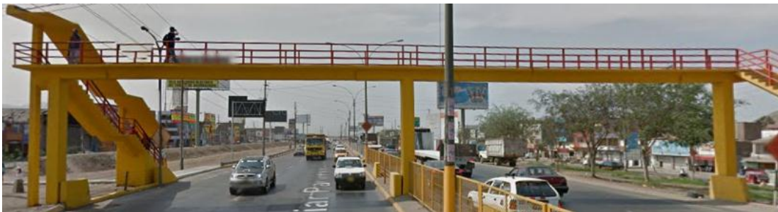
Figura 3.14. Vista fotográfica frontal del puente peatonal La Amistad
