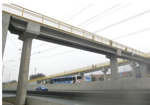
Figura 3.21. Vista fotográfica isométrico del puente peatonal Shangrilla
