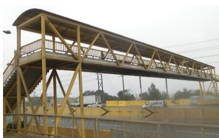
Figura 3.23. Vista fotográfica isométrico del puente peatonal Mariátegui
