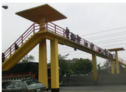
Figura 3.3. Vista fotográfica isométrico del puente peatonal Villa Sol
