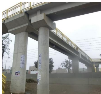
Figura 3.19. Vista fotográfica isométrico del puente peatonal Acobamba
