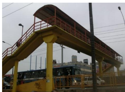
Figura 3.7. Vista fotográfica isométrico del puente peatonal Santa Luisa
