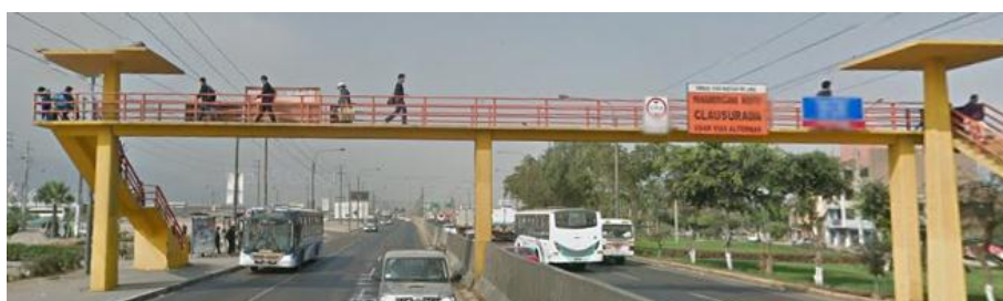
Figura 3.2. Vista fotográfica frontal del puente peatonal Villa Sol
