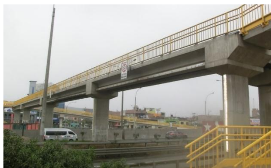
Figura 3.11. Vista fotográfica isométrico del puente peatonal Entrada de Pro
