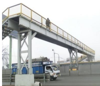
Figura 3.17. Vista fotográfica isométrico del puente peatonal Pro Lima
