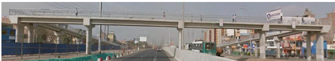
Figura 3.8. Vista fotográfica frontal del puente peatonal San Martín
