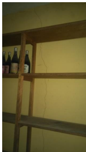
Figura 9 Lesión indirecta. Error de proyecto. Carga axial mal distribuida
