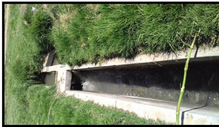
Figura N°18: Canal de desarenador (entrada Ptar)
