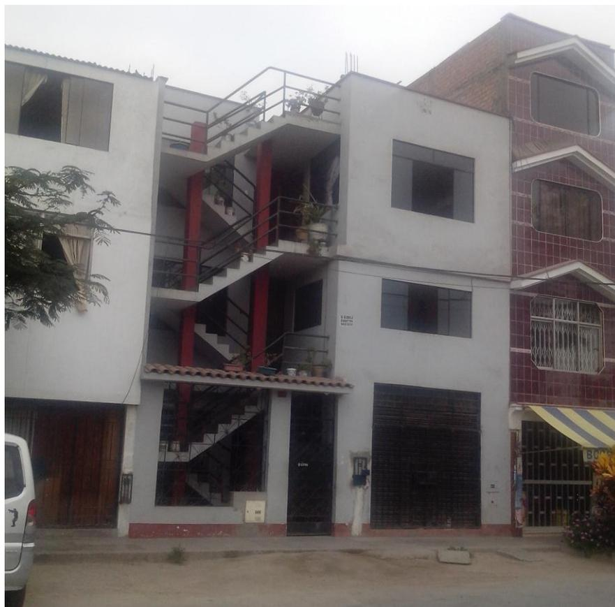
FIGURA 16: Falta de junta sísmica
