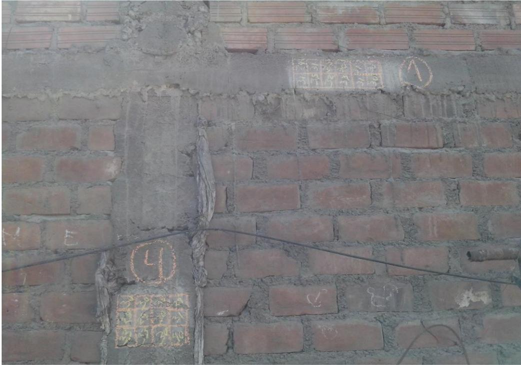
FIGURA 14: Cangrejeras en sus construcciones
