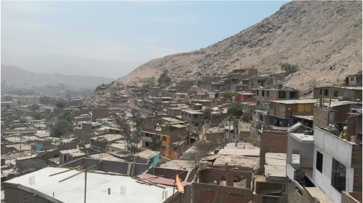
FOTO 1: Vista lateral del A.H. Alto Perú.
