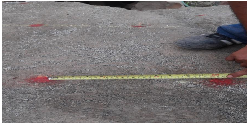
Figura 3.07: Medida del desplazamiento entre agujeros. Fuente: Elaboración propia.
