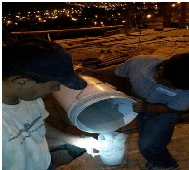
Figura 3.12: El mortero preparado con el cemento expansivo Fuente: Elaboración propia
