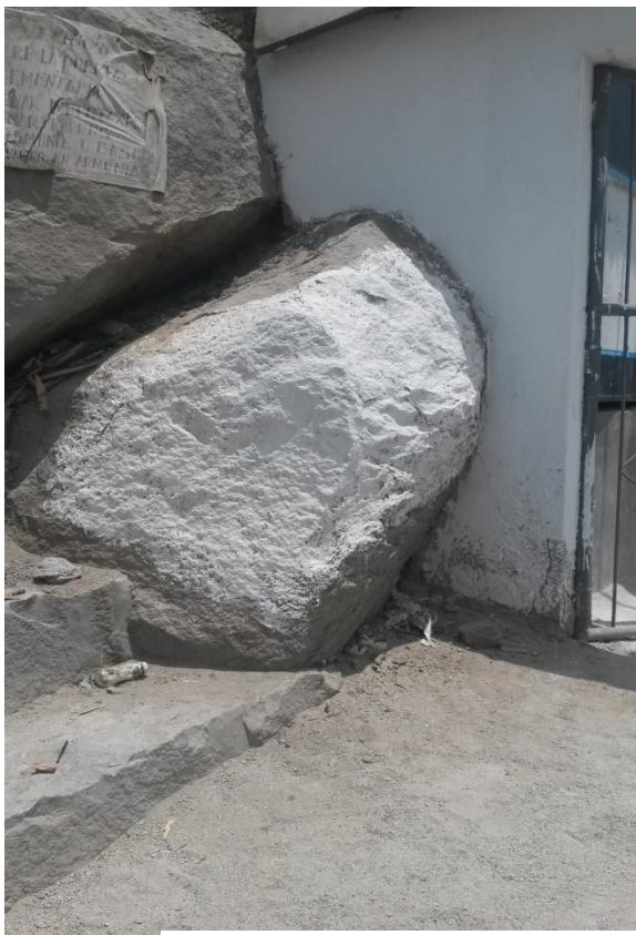
FOTO 3: Rocas unidas en la estructura de las viviendas
