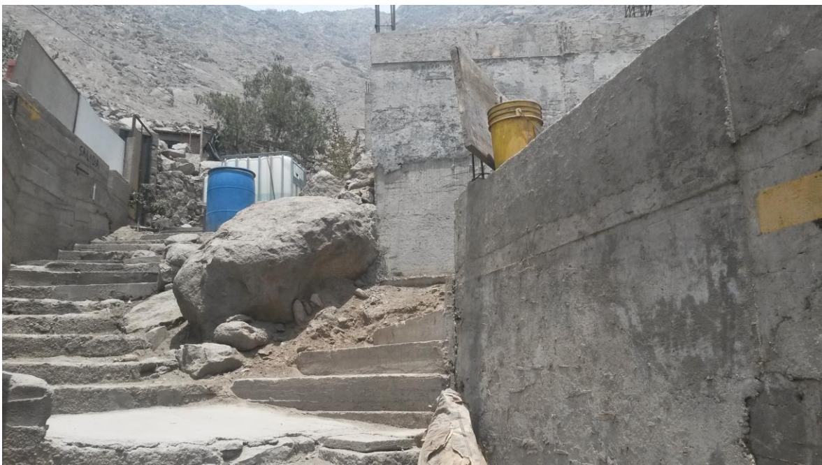
FOTO 7: Rocas ubicadas en los caminos de acceso y salida de las viviendas
