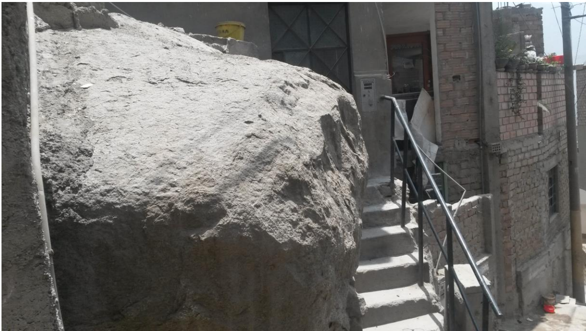
FOTO 6: Presencia de rocas en el ingreso de las viviendas
