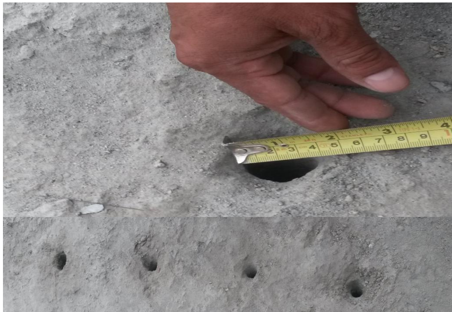
Figura 3.10: Diámetro de perforación Fuente: Elaboración propia.
