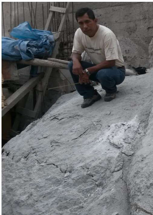
Figura 3.15: Se observa al investigador tomando las medidas de las fracturas de acuerdo a cierto intervalo de tiempo.
