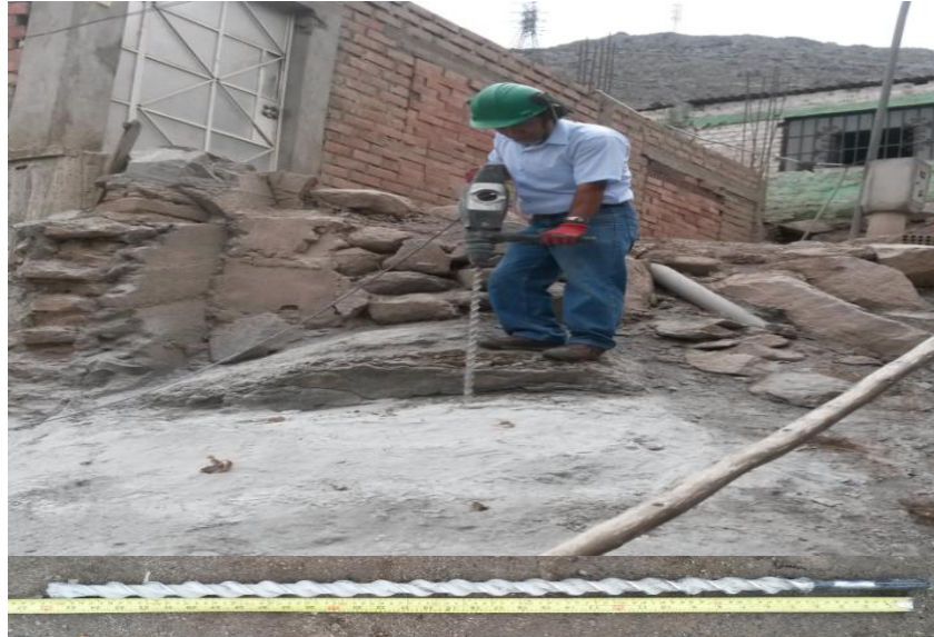
Figura 3. 09: Perforación de barrenos Fuente: Elaboración propia.
