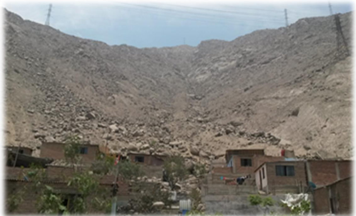
Figura 1.2 Rocas que dificultan las construcciones
