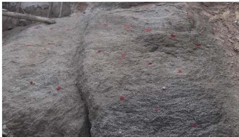
Figura 3.06: Diseño de malla en forma rectangular Fuente: Elaboración propia
