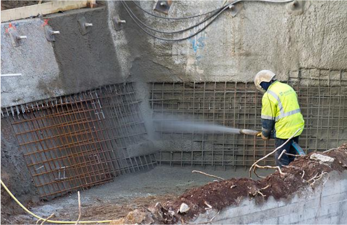
Mortero lanzado en calzada
