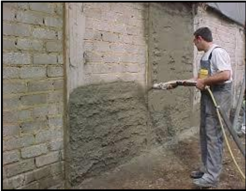
Figura 3. Proyectando mortero en muro donde se aprecia el rendimiento
