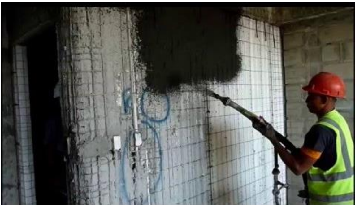
Mortero Lanzado para revocos en muros
