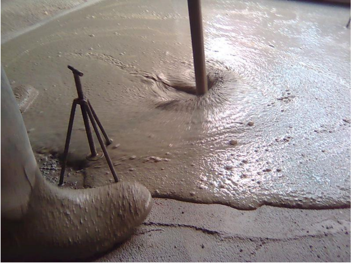
Bombeo de Mortero en contrapisos
