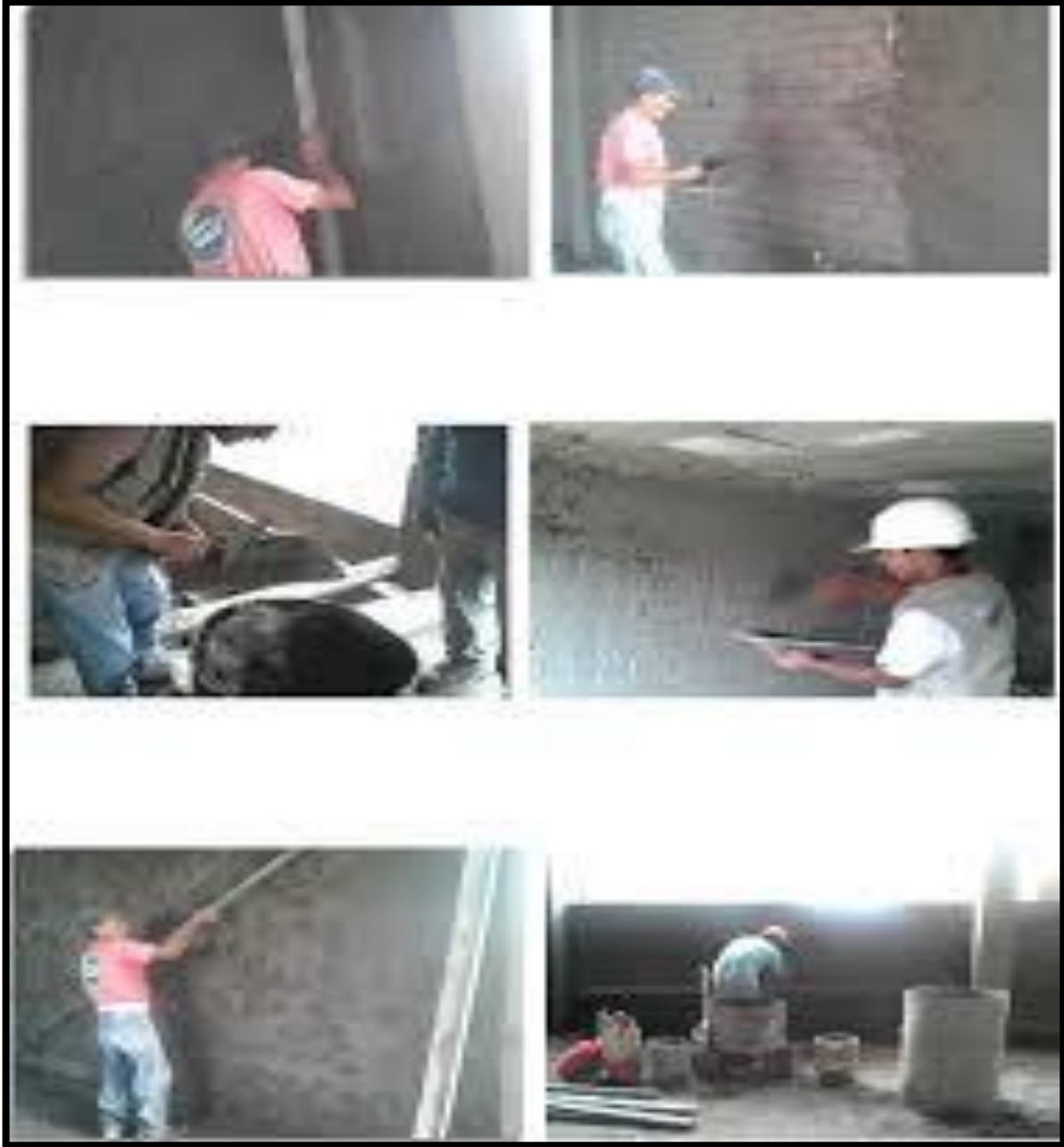
Figura 1. Tarrajeo tradicional, presenta mayor desperdicio.
