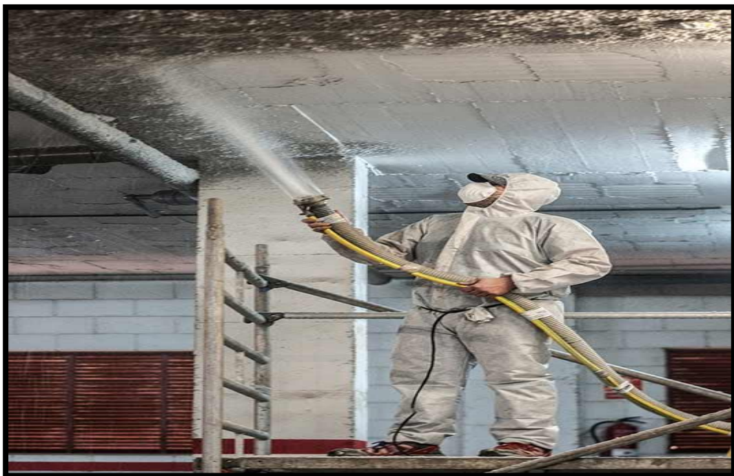
Figura 4. Proyectando mortero en cielo razo
