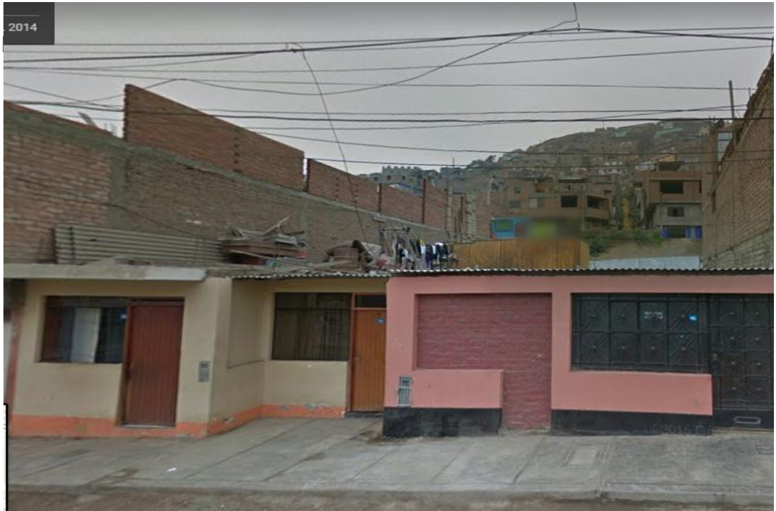
Figura 3.5: Visualización de autoconstrucción de albañilería confinada por etapas según el factor económico y su necesidad, fuente google maps.
