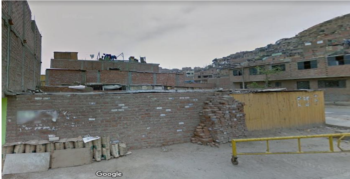
Figura 3. 6: Visualización de muro de albañilería, fuente google maps.
