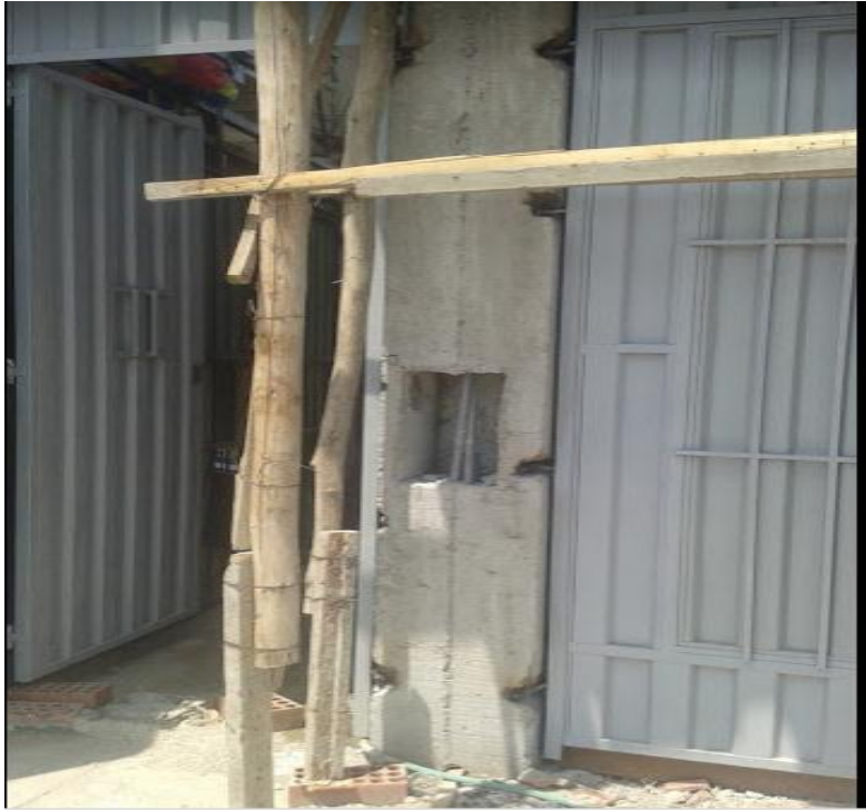
Figura: 3.31: En las figura se aprecia el mal proceso constructivo del concreto armado
