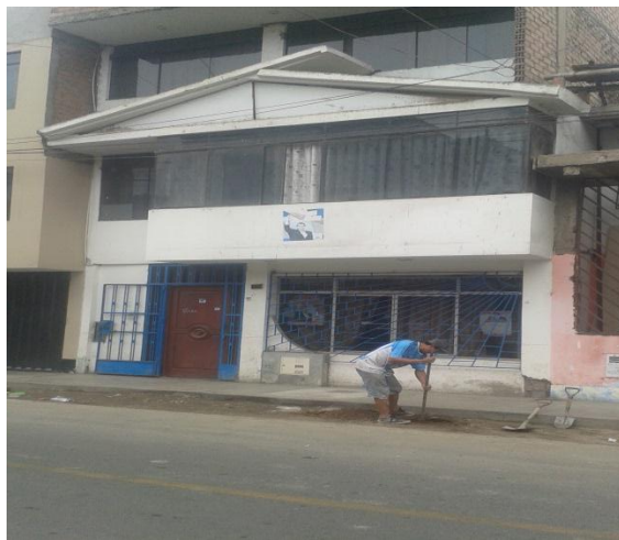
Figura: 3.9: extracción muestra de suelo
