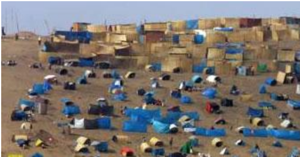
Figura 3.3: Primeros elementos estructurales listones de madera como parantes y las esteras como tabiques, fuente google maps.
