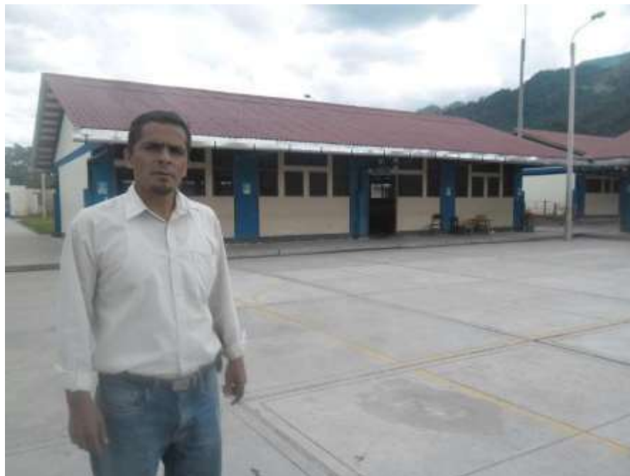
En el interior de la infraestructura de la de la I.E. N° 00903 “San Juan Bautista” – Nueva Cajamarca
