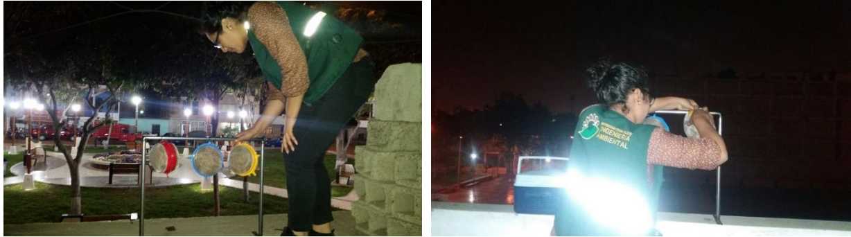
Imagen 7: Instalación final de Instrumento de monitoreo
