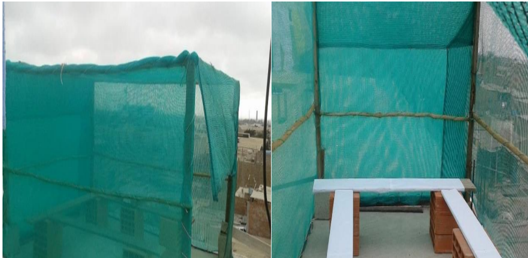
Figura N° 13: Construcción y acondicionamiento de mini invernadero
