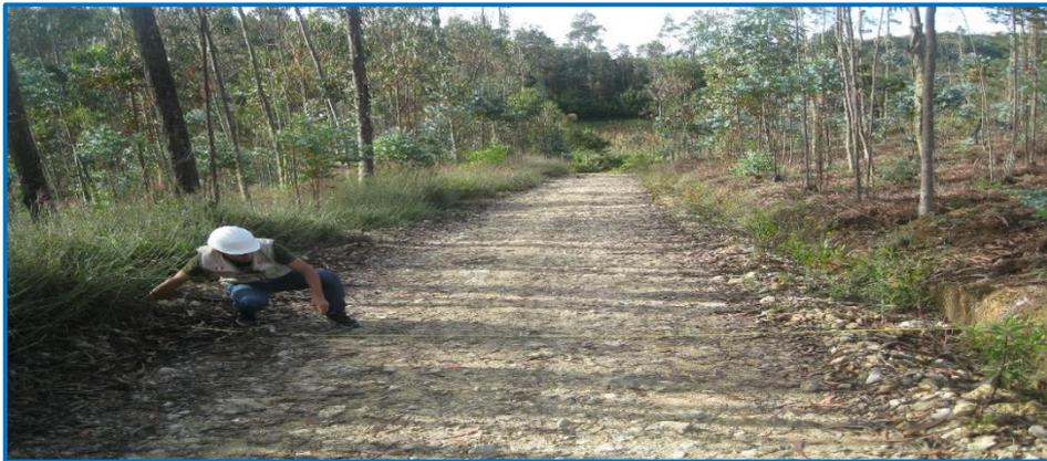
**Figura 85:** Anchos de calzada que varían de 2.50 m a 360 m
