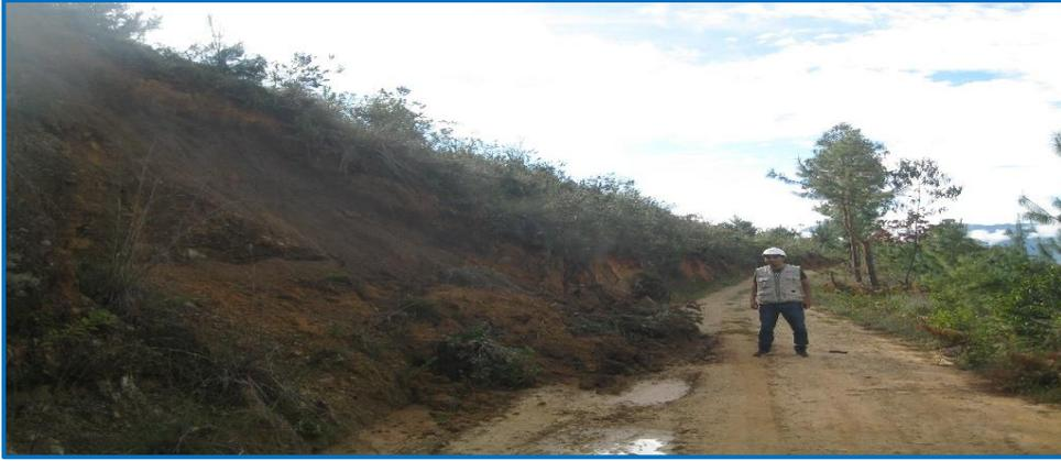
**Figura 81:** Deslizamiento de taludes a lo largo de la trocha.
